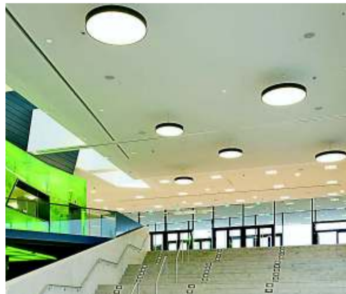
Moderne Beleuchtung sorgt für angenehmes Licht, die schmalen Schlitzleuchten für Wärme und gute Luft.
