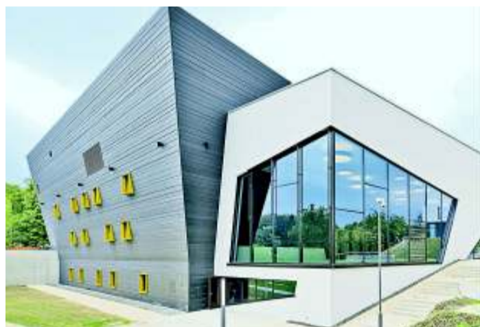
Die imposante Außenfassade des Martin-Hornung-Saals.
