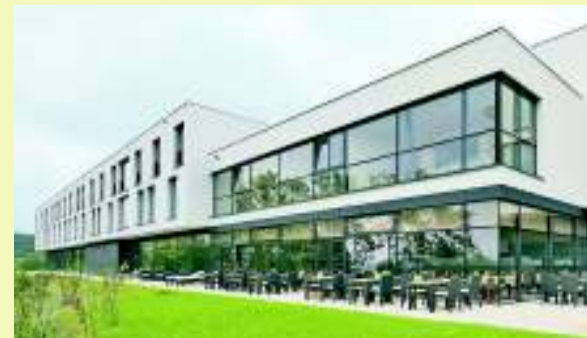
Große Außenterrasse im Gastronomiebereich
