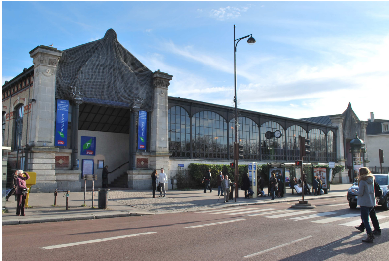
La façade extérieure de la gare, avec ses deux tympans voilés de filets
