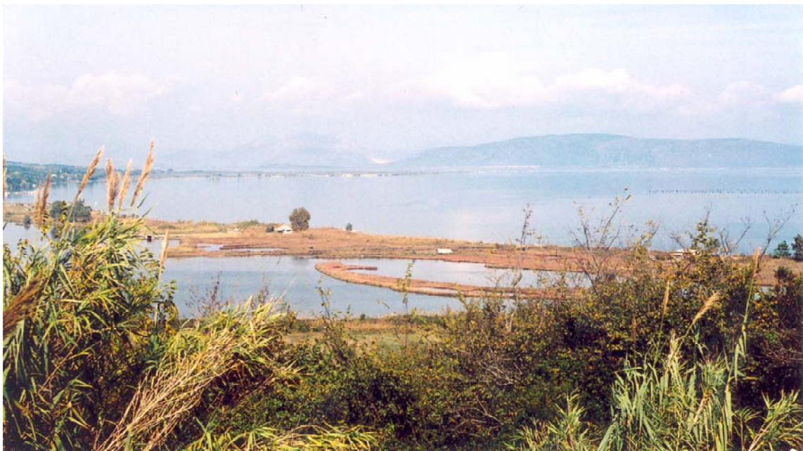
Φωτογραφία 5.9: Το φράγμα της Λιμνοθάλασσας Μάζωμα.
