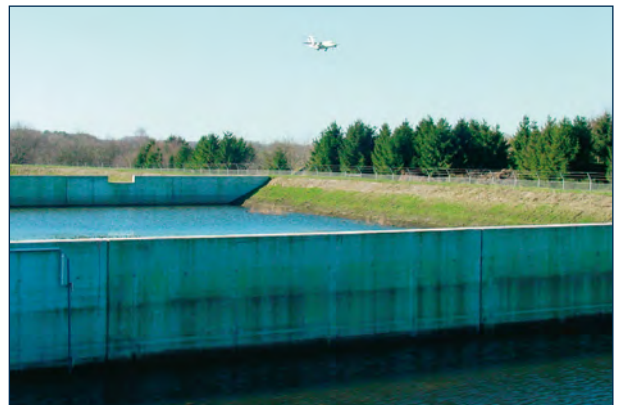
Offenes Regenrückhaltebecken in Kaskadenbauweise
