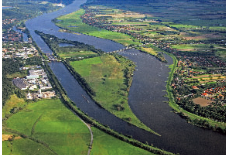
Elbbrücke in Geesthacht, Schleswig-Holstein
