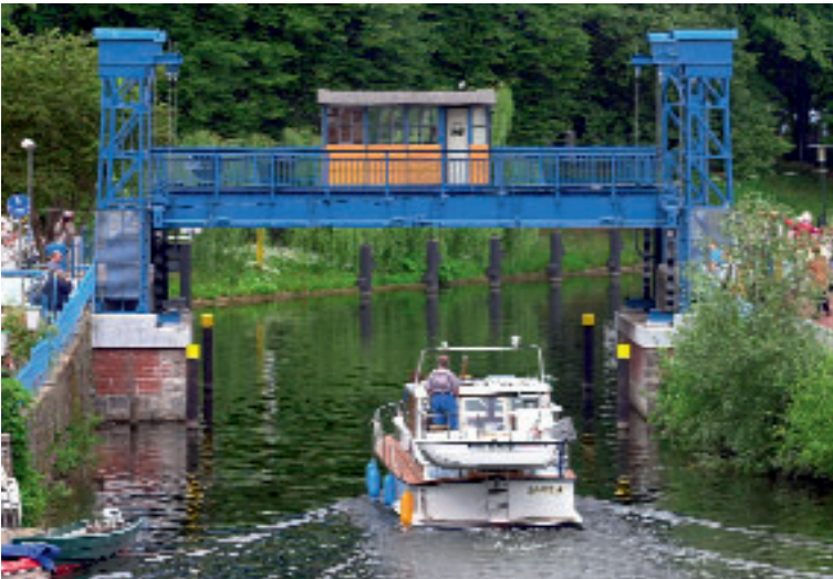
Fluss Elde, Hubbrücke in Plau am See
