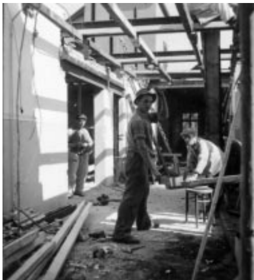
Ausbesserungsarbeiten der Fa. Runkel
