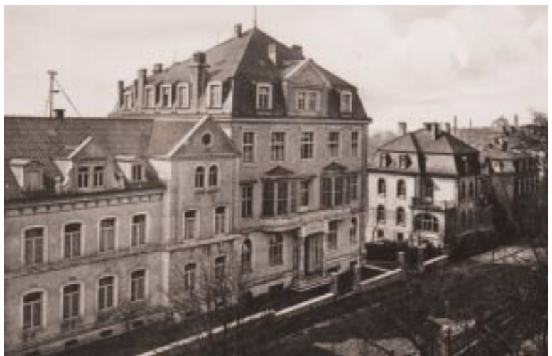
Das Gebäude 1910 von der Brüderstraße gesehen
