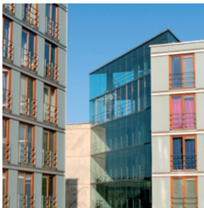
Abbildung 4 (siehe auch obere Bilder auf Seite 6): Auch Bestandsgebäude können Passivhausstandard und hohe Wohnqualität erreichen. Beispiel: Neue Bourse in Wuppertal
