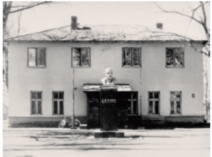
Ein typisches Architekturbeispiel der Chruschtschow-Zeit in Kleinstädten und auf dem Land.
