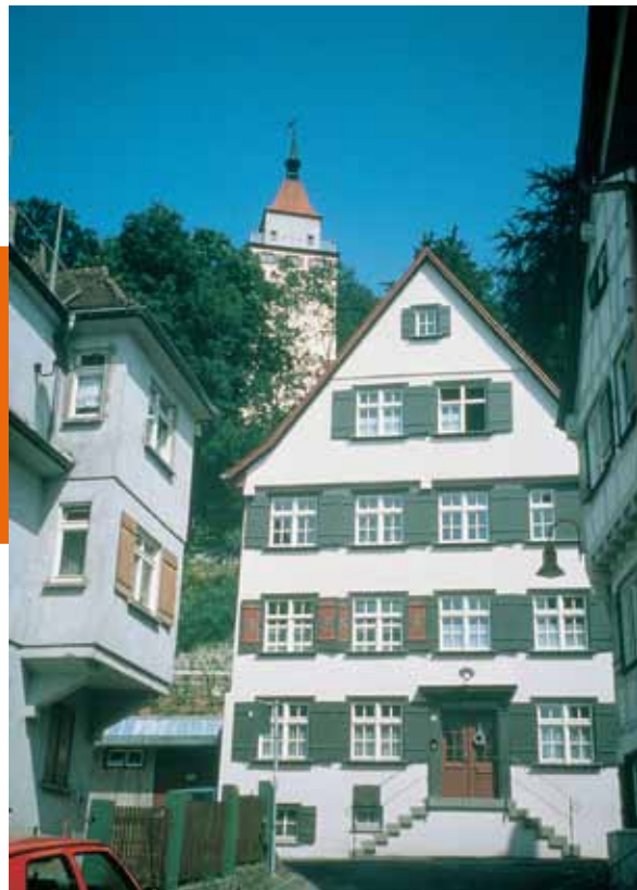
Weberberggasse 31 nach der Sanierung, Quelle: Goessler Photographie, BC
