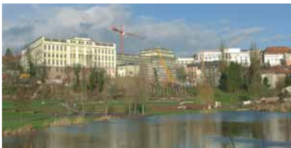
Ehemalige Schuhfabrik Rheinberger im Umbau, Quelle: FORUM
