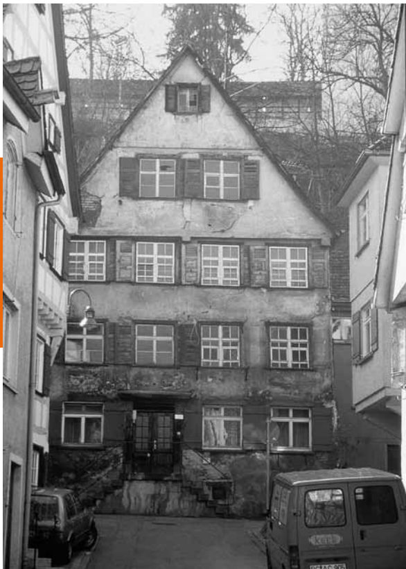
Weberberggasse 31 vor der Sanierung, Quelle: Stadt Biberach
