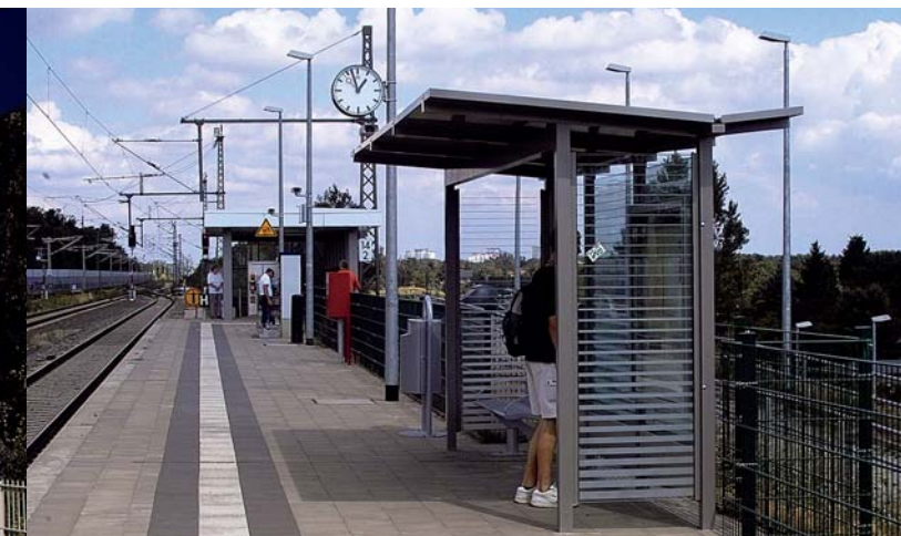
Modernisierte Verkehrsstation Teltow
