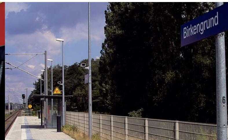
Kompletter Neubau der Verkehrsstation Birkengrund
