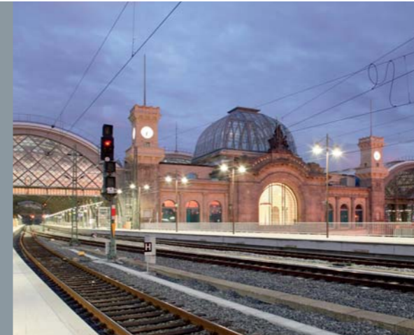
Neubau und Wiederherstellung der Infrastruktur Hauptbahnhof Dresden
