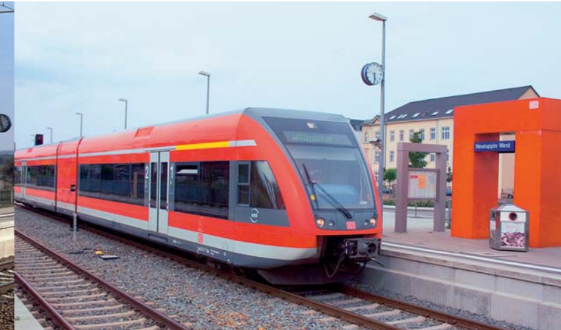
Modernisierte Verkehrsstation Neuruppin West
