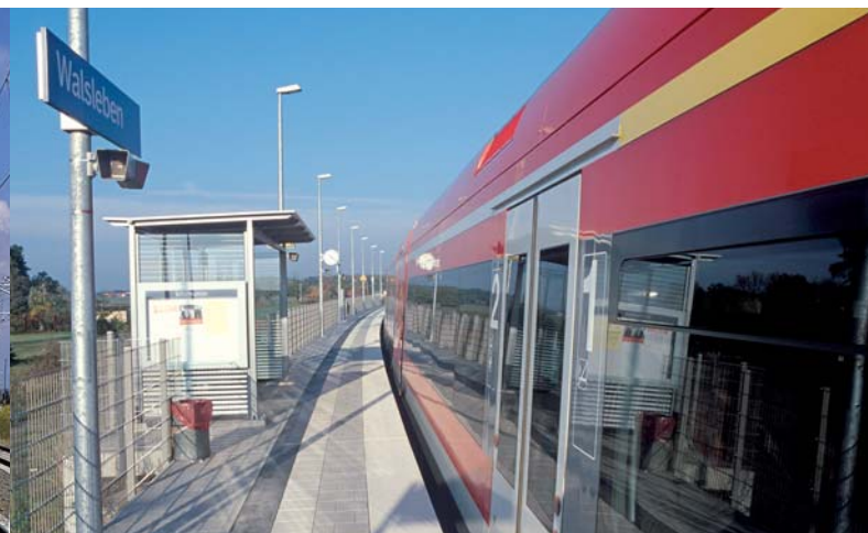
Modernisierte Verkehrsstation Walsleben
