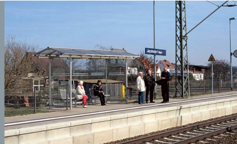
Modernisierte Verkehrsstation Jacobsdorf
