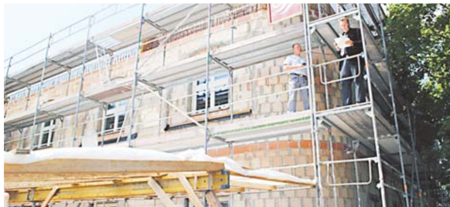
Seit Mitte Juli ist der Rohbau der neuen Kita am Elsflöther Weg 32 fertig. Foto: Ulrike Kiefer
