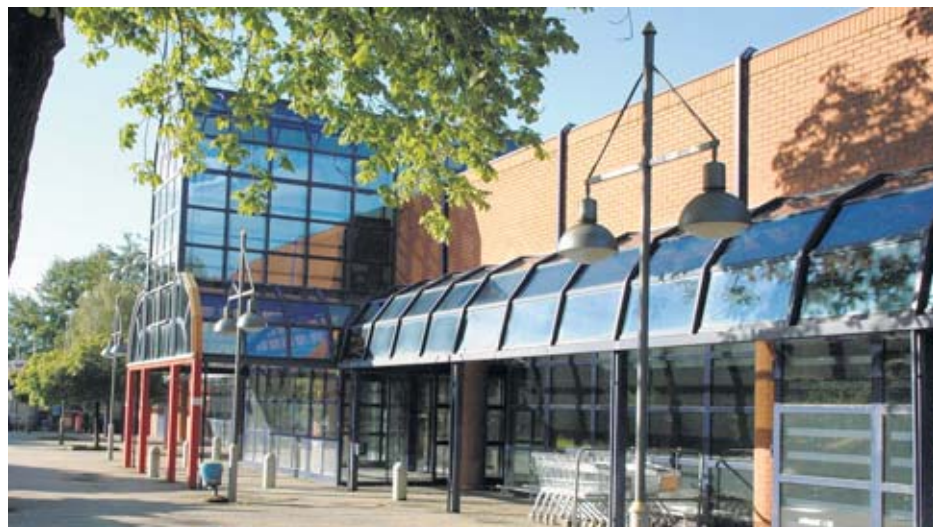
Das „Britannia Centre“ an der Wilhelmstraße könnte bald anders aussehen: Dem Bauamt liegt ein Antrag auf Teilabriss und Neubauten vor. Foto: Michael Uhde
