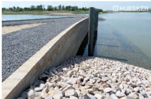
Einbau der Geokunststoffbewehrung.
