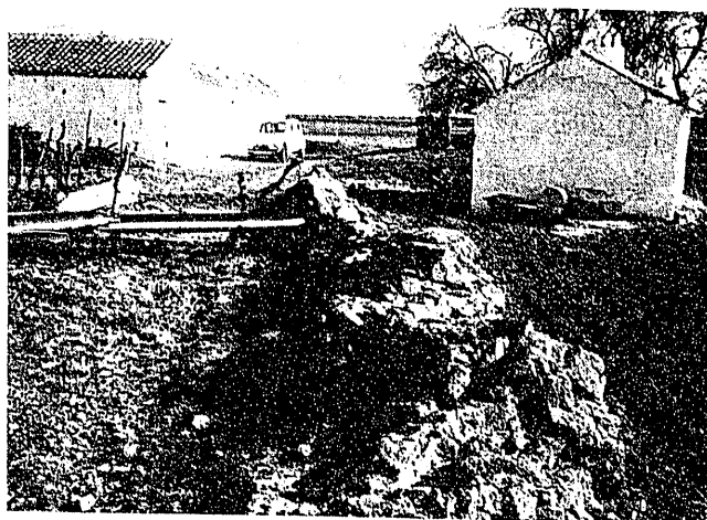
Fig. 40.—Zona final de estribo derecho.
