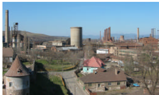
Abbildung 5: Stahlwerk Siderurgica S.A. in Hunedoara Foto: Basilautzkis 2003.
