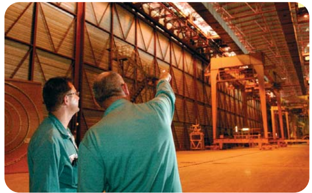
EURODIF Production : ronde de surveillance des installations
