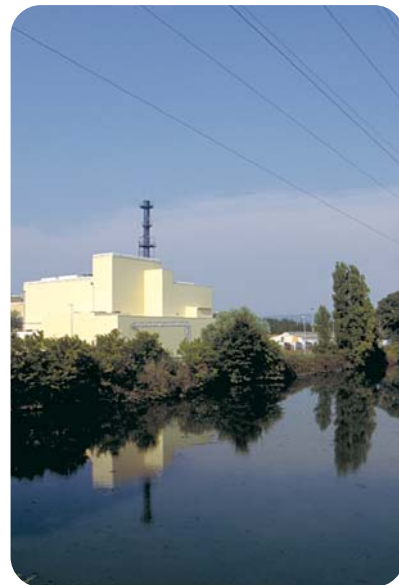
Bassin de récupération des eaux pluviales
