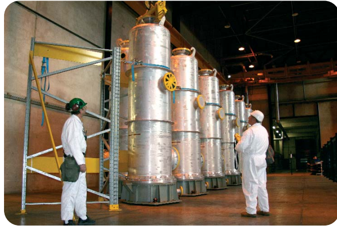
AREVA NC - maintenance de diffuseurs
