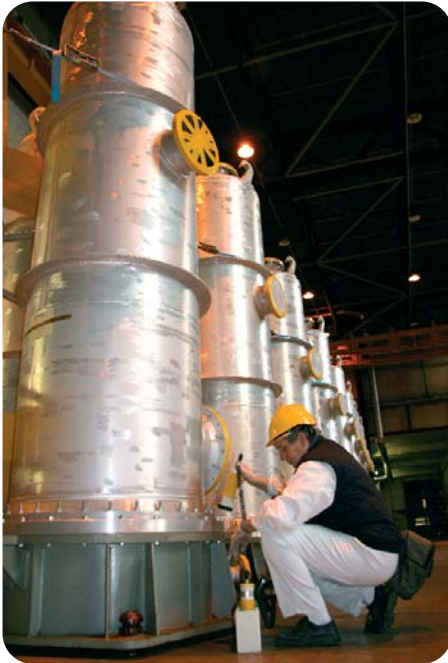
Contrôle radiologique des diffuseurs
