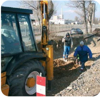
Réparation d'une canalisation d'eau
