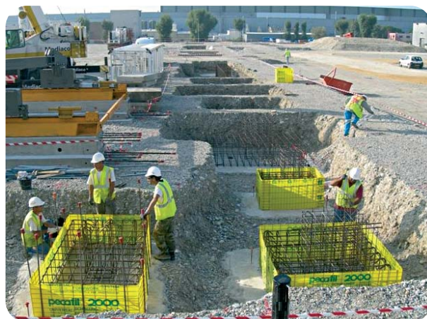
Coulée du premier béton
