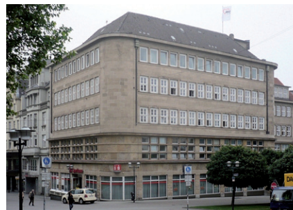
1927–1928: Büro- und Geschäftshaus „Allbau-Haus“ für die „Allgemeiner Bauverein Essen AG“ in Essen, Pferdemarkt / Viehofer Straße (Quelle: Wikipedia)
