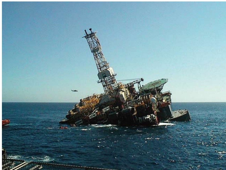
Abb. 1 | Die damals weltgrößte Förderplattform PetrobrasP36 sank im März 2001 nach einer Explosion vor Brasilien in einer Wassertiefe von 1300 m.
