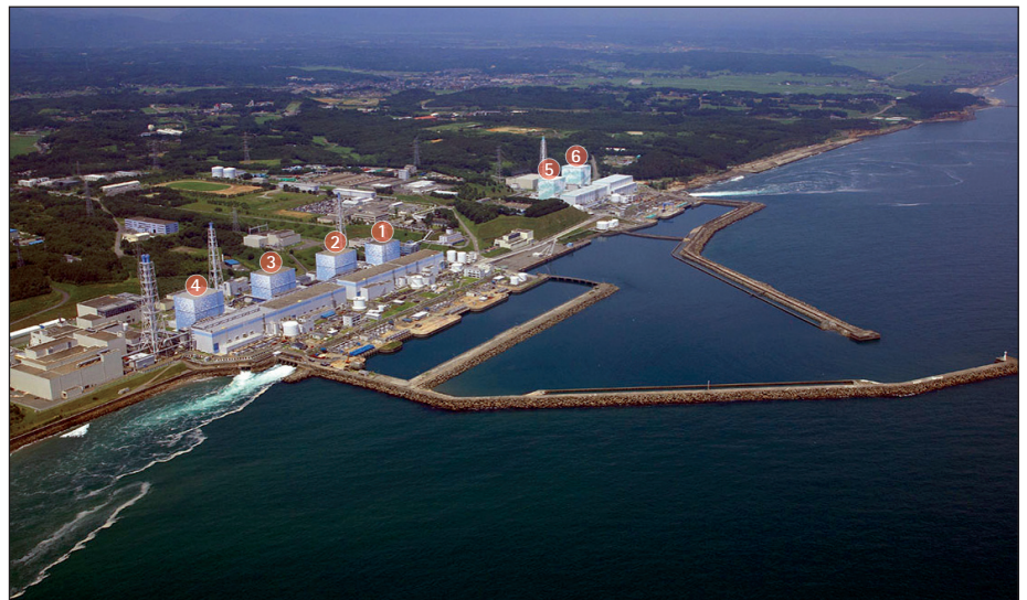
Abb. 2: Luftaufnahme des KKW Fukushima-Daiichi vor dem 11.03.2011
