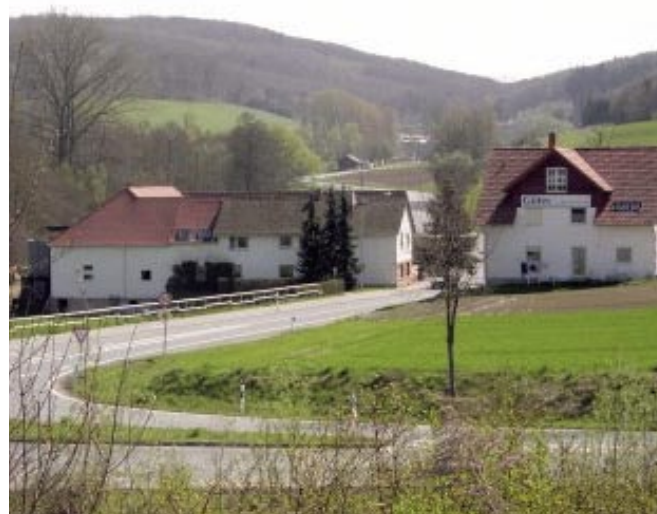
Die Pinkmühle im Tal des Waschenbaches an der Kreisstraße nach Waschenbach. Im Hintergrund die ersten Häuser des Nachbarorfes.
