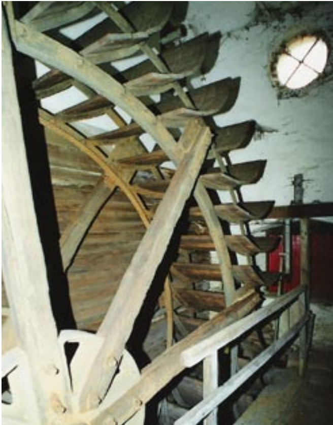
Das 5 m hohe Wasserrad der Pulvermühle, das einzige noch funktionsfähige im Mühlthal. Seit der Explosion mit Todesopfern 1856 bei der Herstellung von Schießpulver wurde hier nur noch Getreide gemahlen. Seit 1995 kann die Pulvermühle für den Eigenbedarf elektrischen Strom erzeugen.
