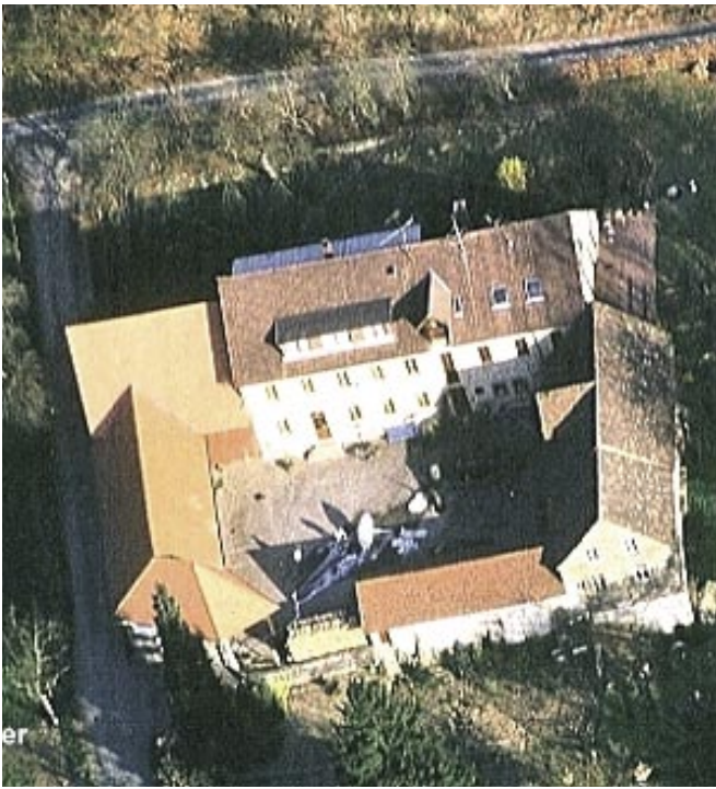
Das fränkische Geviert der Waldmühle auf dem Beerbach ist als moderne Wohnanlage erhalten, Foto: Georg Seeger
