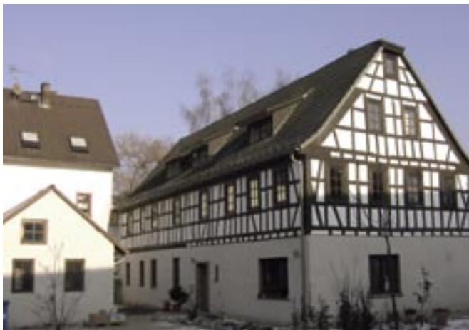
Die beiden Bruchmühlen, teils mit alter Bausubstanz, teils umgebaut und erweitert, dienen heute Wohn- und Gewerbebezwecken
