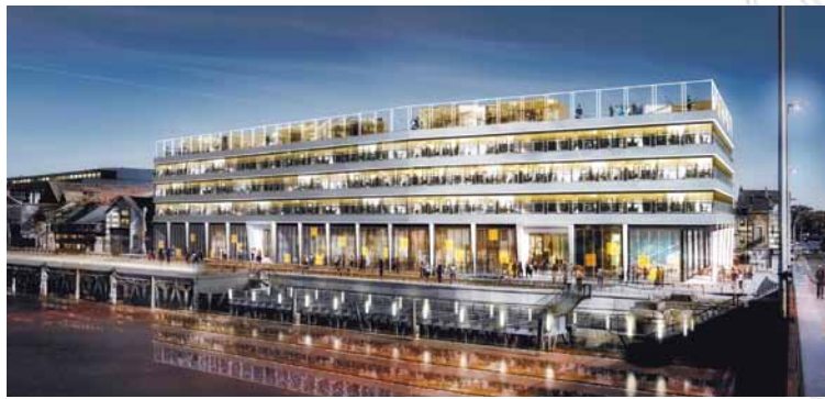
L'immeuble d'Harmonie Atlantique et son nouveau look.
