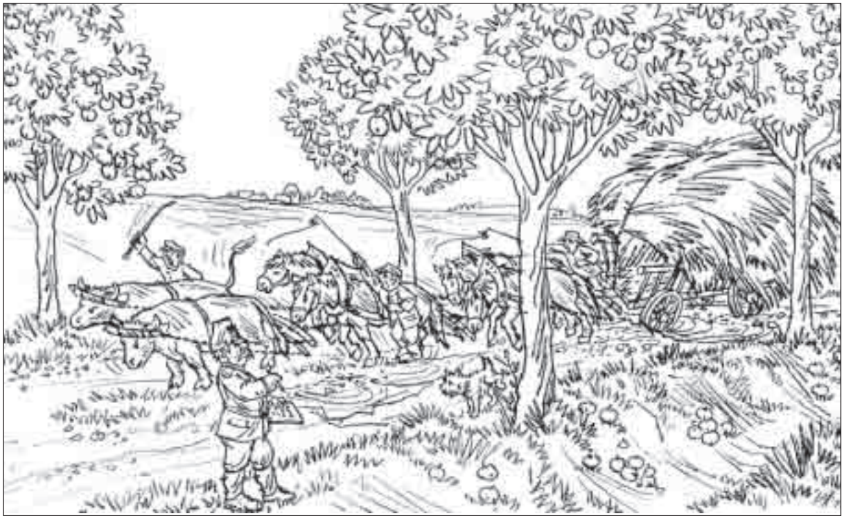
Straße 19: Gendarm Mühlhaus berichtet am 25. August 1900 über den Straßenzustand, im Hintergrund Woltersdorf überlassen von: Dr. Borns
