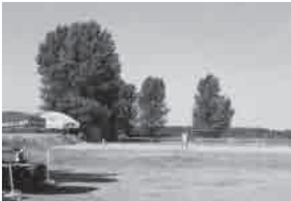
Bild 14: Bau der neuen Tennisanlage an der Radrennbahn
