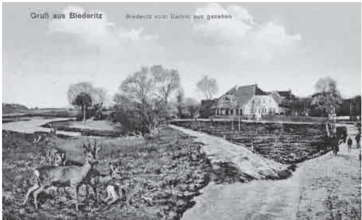
Ort. 79 Blick von Umflutdeich auf die „Alte Oberförsterei“ um 1918 überlassen von: Herrn Dr. Borns
