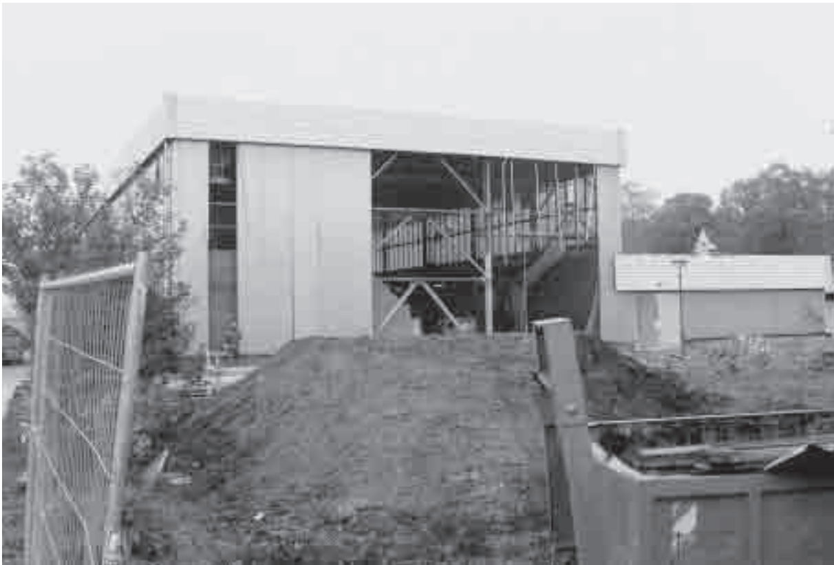
Bild 45: Die ersten Abrißarbeiten
