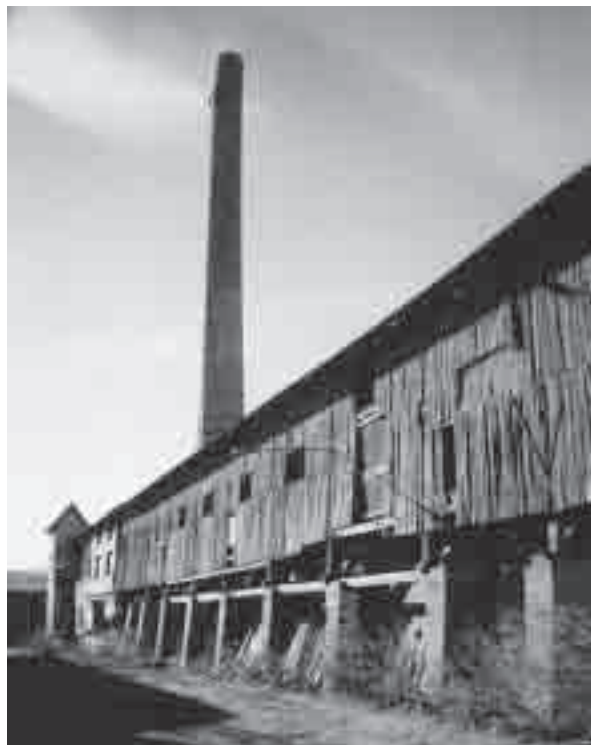
Ziegel 28: Der stillgelegte Ringofen der Ziegelei Vehlitz, die Ofenbühne mit Dach ist noch einigermaßen erhalten überlassen von: Herrn Dr. Borns
