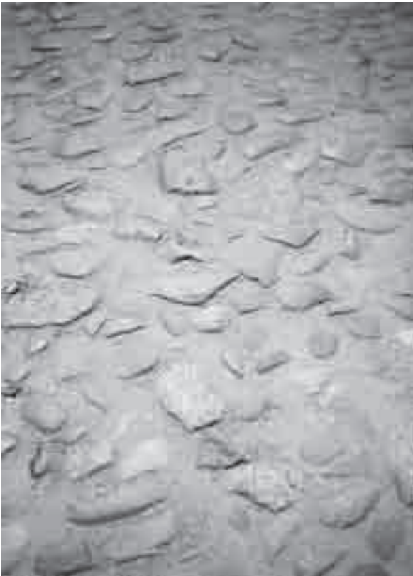
Straße 16: Findlingspflaster in der Breiten Straße beim Förster 1997 überlassen von: Herrn Dr. Borns
