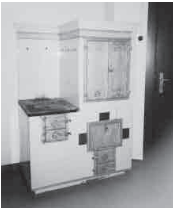
Ort. 13 Vom Ofensetzer errichtete kombinierte Koch- und Backgelegenheit 1910. Hinter den zwei großen eisernen Türen befindet sich die Grude, darunter der mit Holz und Kohle beheizbare Backofen, links die zwei Kochstellen mit herausnehmbaren Ringen, um Töpfe oder Pfannen direkt auf das Feuer setzen zu können. überlassen von: Herrn Dr. Borns
