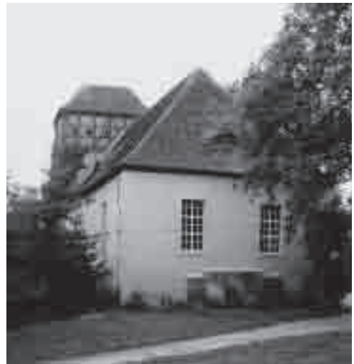
Abb. 10: ev. Kirche Biederitz, Ansicht von Südosten
