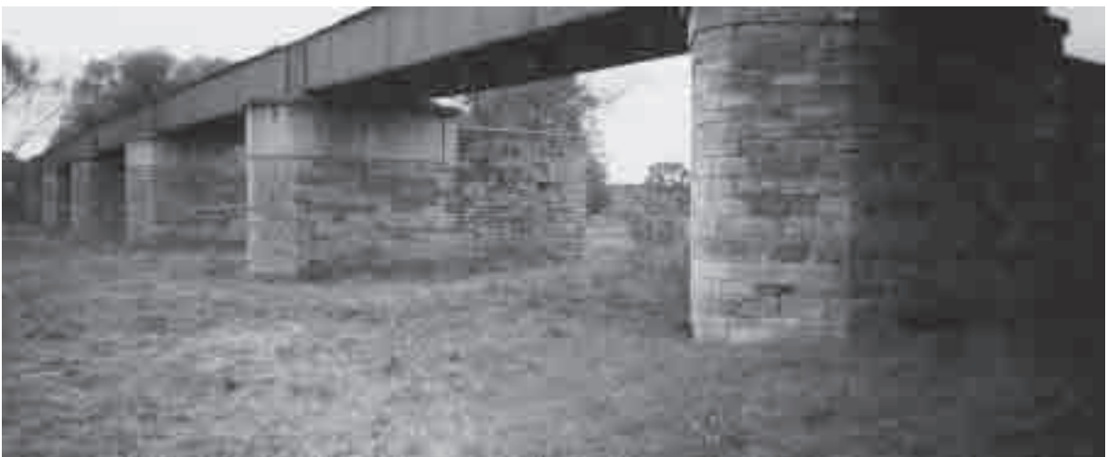
Bahn 03: Eisenbahnbrücke in Heyrothsberge, gut erkennbar die breiten Pfeiler zur Aufnahme des 2. Gleises überlassen von: Herrn Dr. Borns
