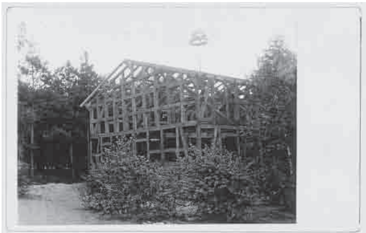
Ort. 32 Die Richtkronen ist gesetzt 1929 überlassen von: Frau Friedrichs
