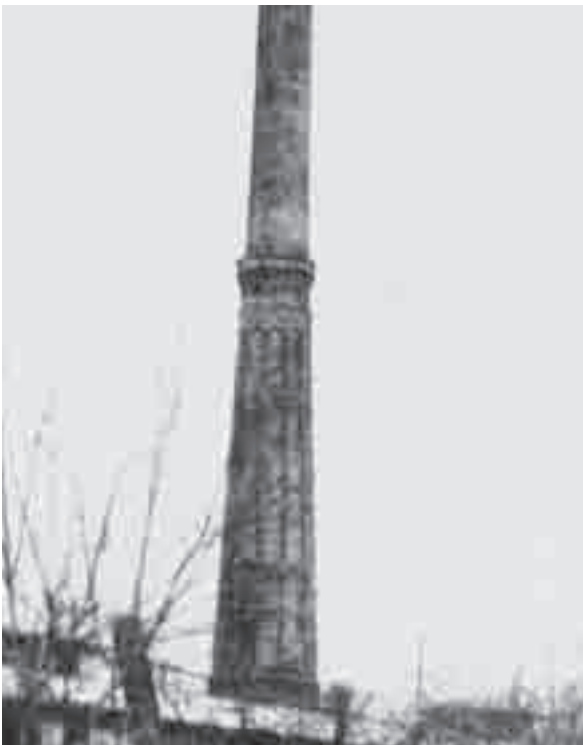
Ziegel 24: Der reich verzierte Ringofenschorn- stein der Ziegelei an der Biederitzer Straße 1958 überlassen von: Herrn Schöchert
