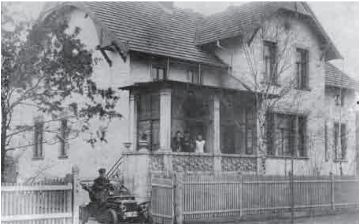
Ort. 79 Blick von Umflutdeich auf die „Alte Oberförsterei“ um 1918 überlassen von: Herrn Dr. Borns
