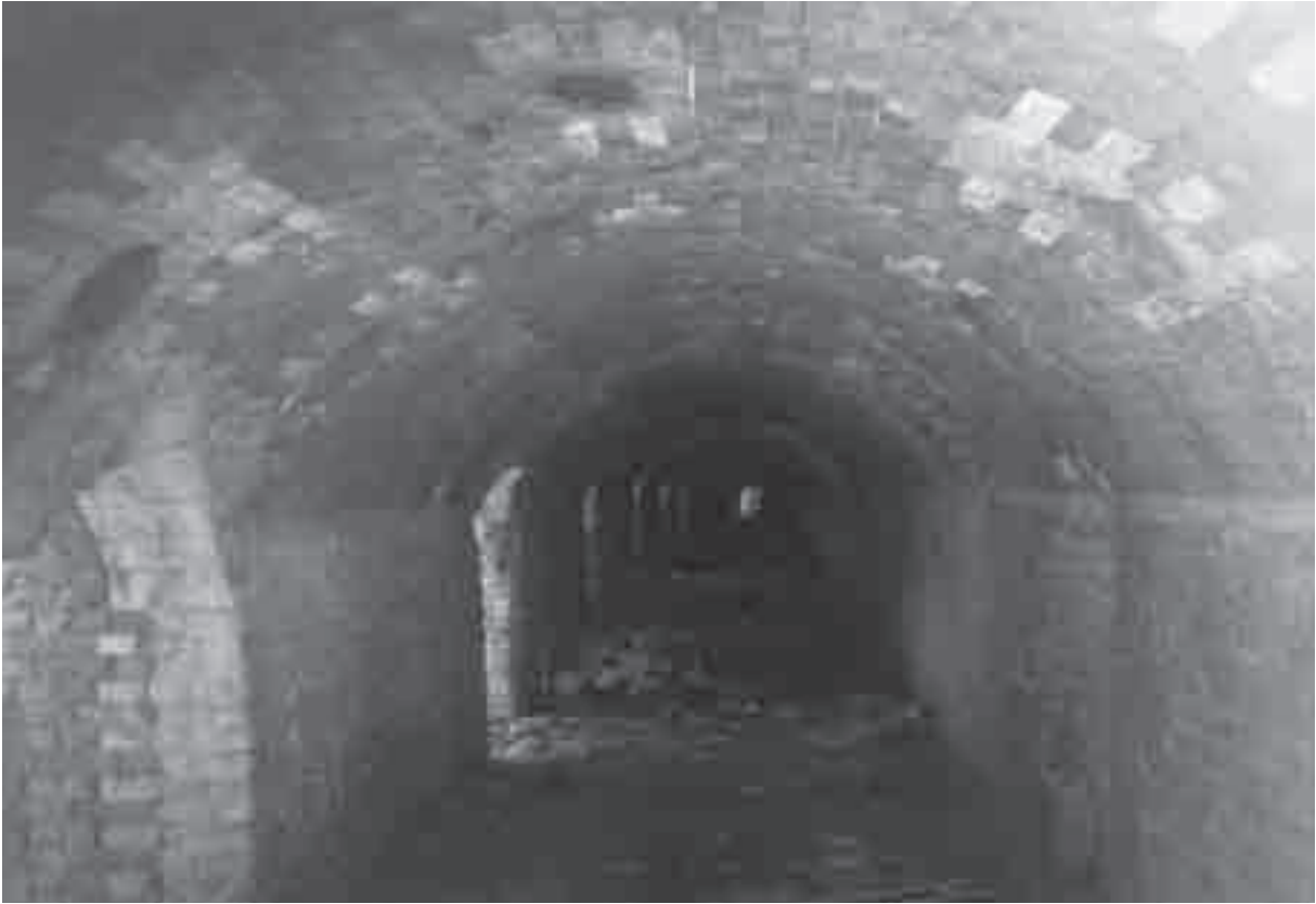
Ziegel 21: Ringbrennofen, deutlich die Löcher in dem Gewölbe für die Kokszuführung zu erkennen überlassen von: Herrn Dr. Borns
