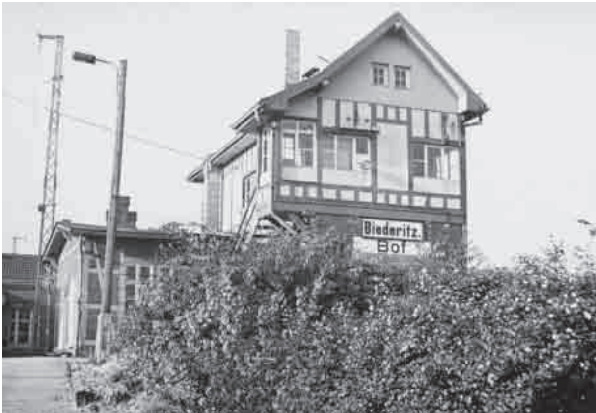
Bahn 09: Gleisbildstellwerk überlassen von: Frau Mittmann
