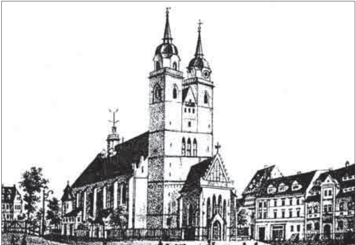
Ort. 05 Telegrafestation Nr. 14 auf dem Dach der Kirche St. Johannes in Magdeburg überlassen von: Herrn Arndt
