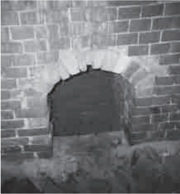
Ziegel 18: Rauchabführung aus dem Brennraum in der Ziegelei Heyrothsberge überlassen von: Herrn Dr. Borns
