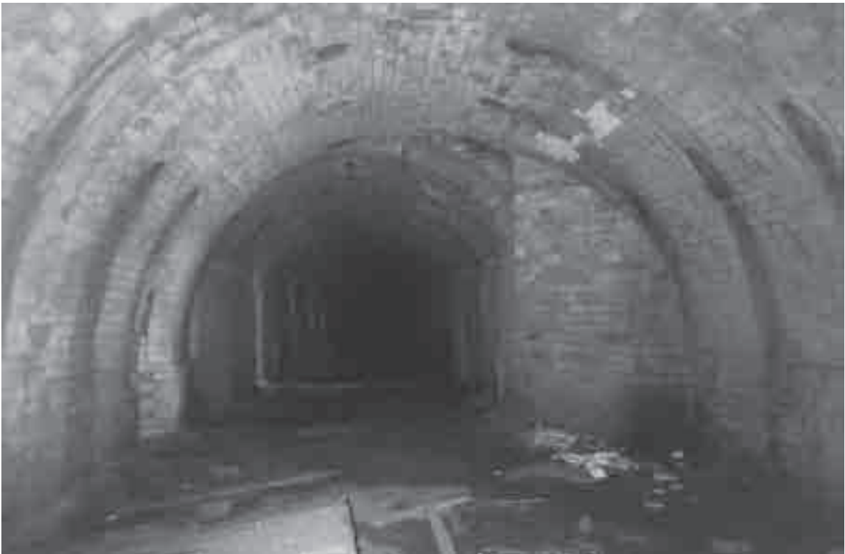
Ziegel 22: Die Ringofenverlängerung aus dem Jahr 1880 überlassen von: Herrn Dr. Borns
