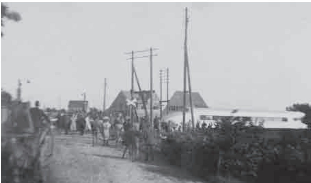
Bahn 19: Schienenzeppelin in Höhe der Woltersdorfer Straße 1931 überlassen von: Herrn Mildner
