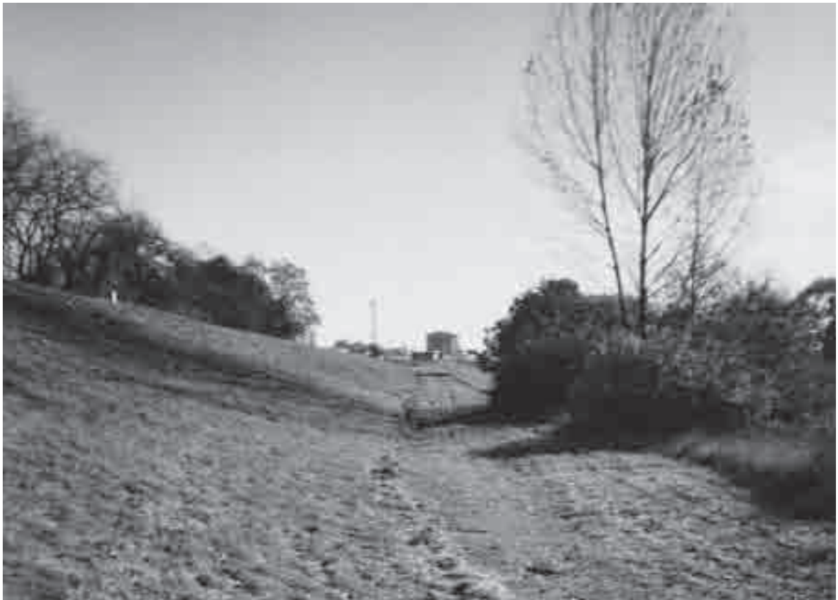
Ziegel 38: Auffahrrampe auf die Krone des Umflutdeiches an der alten Eisenbahnbrücke überlassen von: Herrn Dr. Borns
