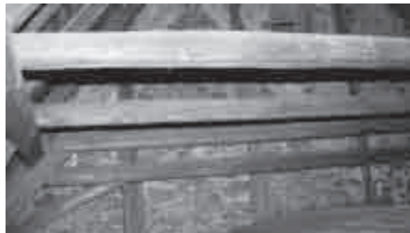
Abb. 6: ev. Kirche Biederitz, Ansatz des Dachstuhls vom romanischen Vorgängerbau auf dem Dachboden
