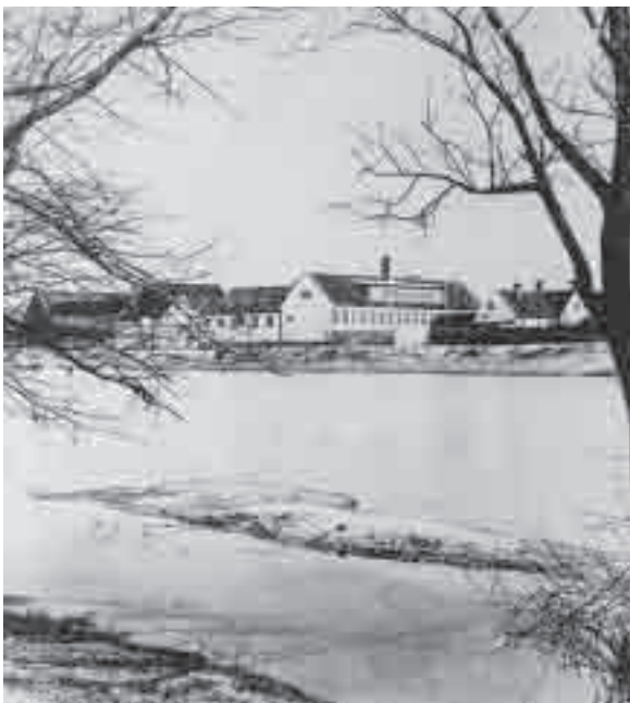
Ort. 28 Die Neue Schule, Blick über die Biederitzer See 1931, Foto: Schaeffer überlassen von: Herrn G. Lüdicke
