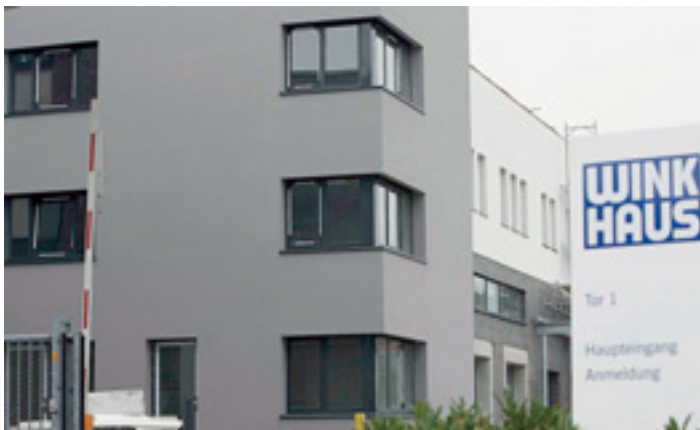
Im Neubau an der August-Winkhaus-Straße werden die Medienzentrale, das Lager und das Service Center für die Produktion der Fenstertechnik untergebracht. Foto: Winkhaus
