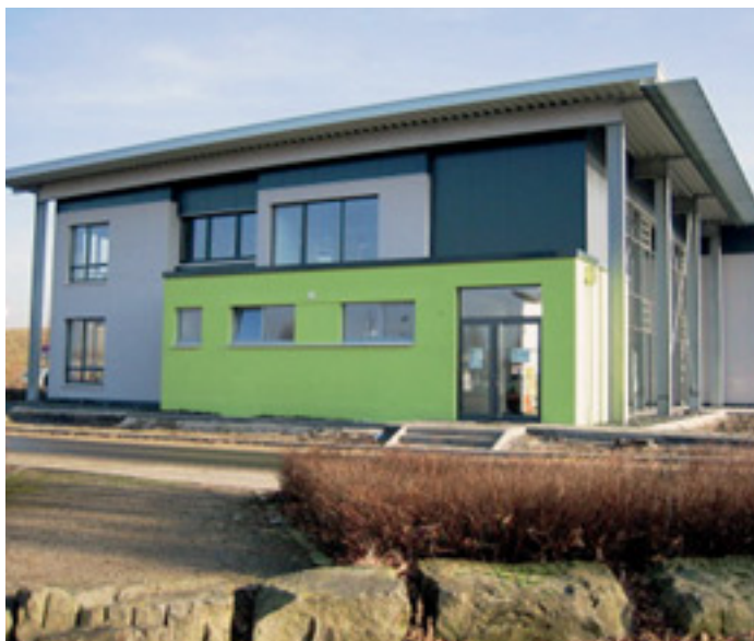
Ein Zentrum für Ingenieure entsteht in Castrop-Rauxel.
