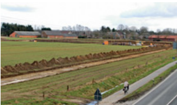
Das Erweiterungsareal des Industrieparks Bocholt wird bereits erschlossen.
