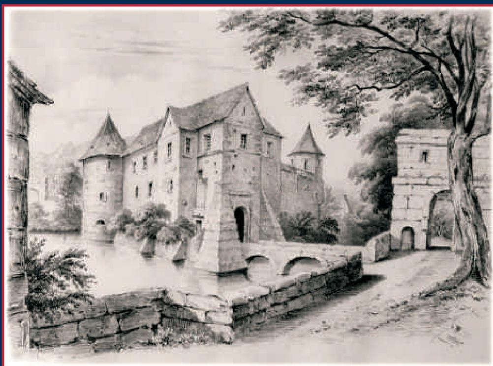
Nach der Zerstörung 1553 wurde der zum Dorf blickende Südflügel um ein drittes Stockwerk erhöht, der Nordflügel aufgefüllt und in einen rundumlaufenden Wehrgang integriert, der südwestliche Turm als runder Kanonenturm ummantelt. Eventuell wurde auch der innere Zwinger an der Ostseite damals überbaut. Der dreigeschossige Westtrakt wurde zwischen 1611 und 1621 über einem älteren Erdgeschoss erbaut.
