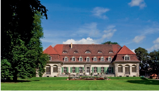
Abb. 9: Südliche Ansicht des Schlosses.
