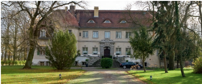
Abb. 10: Eingangsbereich des Schlosses.
