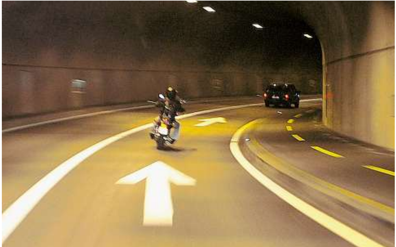
Bei nasser Fahrbahn rutschig: Die aus Sicherheitsgründen übergrossen Richtungspfeile, die im Mositunnel und in den Tunnels auf der Axenstrasse mitten auf die Fahrbahn gemalt wurden, sorgen unter Motorradfahrern für Ärger. Bild R. Vercellone
