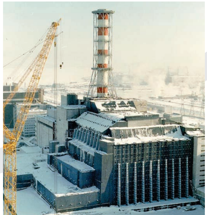
Bild 06: Der Sarkophag um den Block 4 des Kernkraftwerks Tschernobyl nach der Fertigstellung
