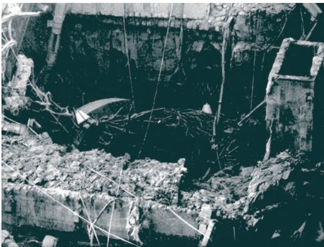
Bild 04: Hubschrauberansicht des zerstörten Reaktorschachtes des 4. Blocks und das beschädigte Dach des Maschinenraumes (September 1986)
