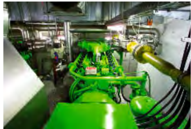
Abb. links: Seit 2002 betreibt Mainova im Tropicarium des Palmengartens ein Blockheizkraftwerk. Abb. oben: Blick vom Generator zum Motorenmodul.
