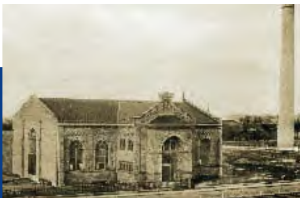
4 Kraftwerk West in der Gutleutstraße um 1895
