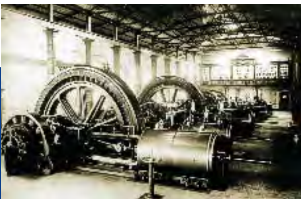
1903 arbeiten vier Kolbendampfmaschinen.
