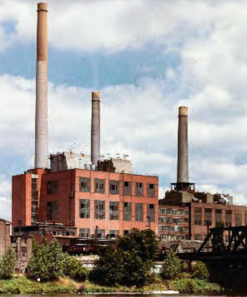
Abb. links: Mit Fertigstellung des letzten Bauabschnitts von Block 1 (1964) steigt die Leistung des HKW West auf 152 MW.
