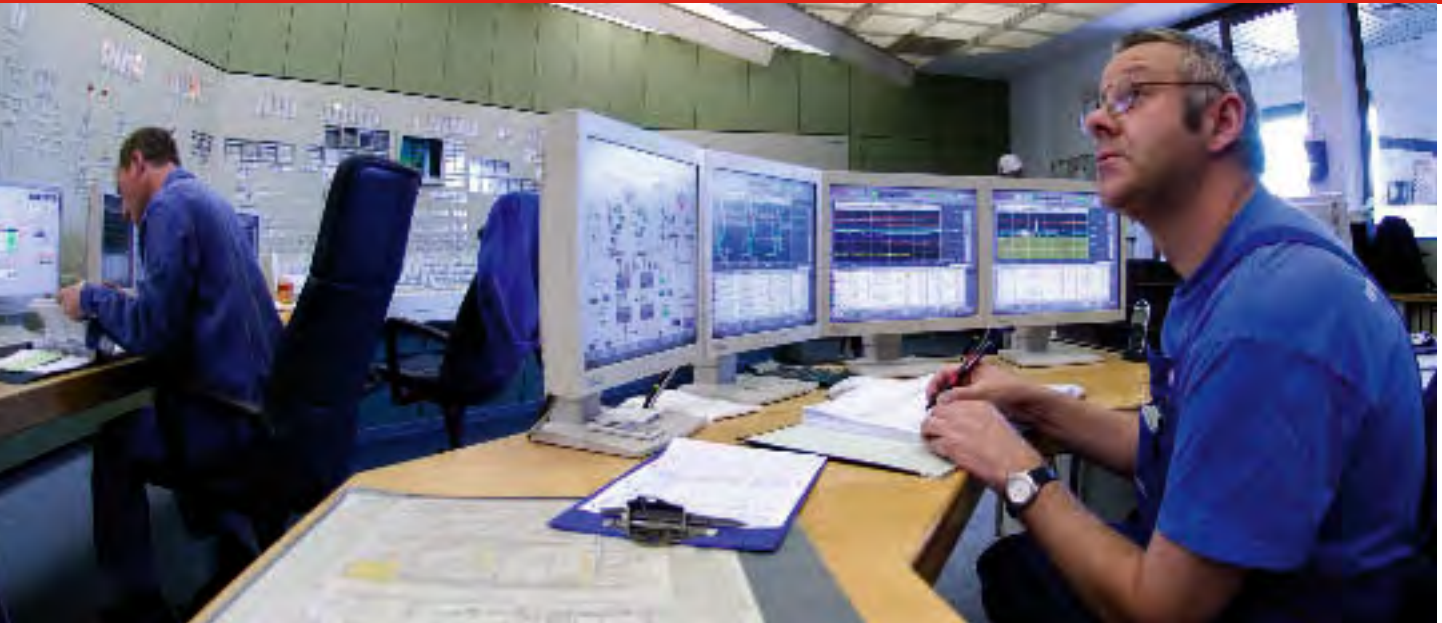
Abb. oben: Blick in die Schaltwarte des HKW West. Abb. unten: Jede von über 4.500 Einzelkomponenten ist im Leitsystem abgebildet. Eventuelle Fehlerquellen werden so sofort lokalisiert und behoben.
