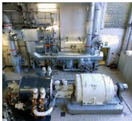
Abb. links außen: Obere Kesseltrommel der Kessel 2 und 3 mit Wasserstandsanzeige. Abb. links: Gegendruckturbinen und 4,0-MW-Generator
