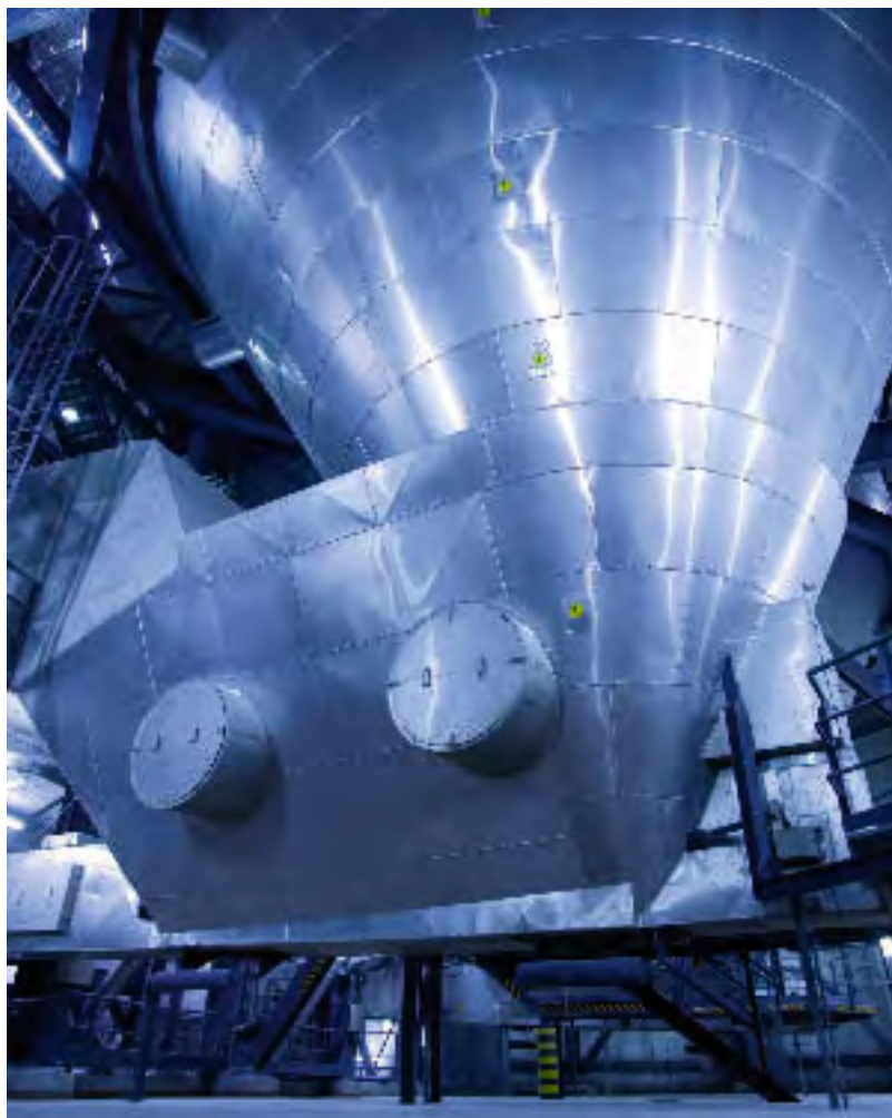
Abb. rechts: Unterer Teil des Sprühabsorbers (Teil der Rauchgasreinigungsanlage) mit Materialabzug für die REA-Rückstandsprodukte
