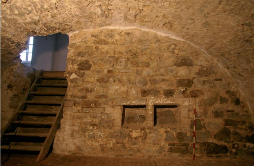
Westseite des tonnengewölbten Kellers mit dem nachträglich eingefügten Zugang und den beiden Wandnischen.
