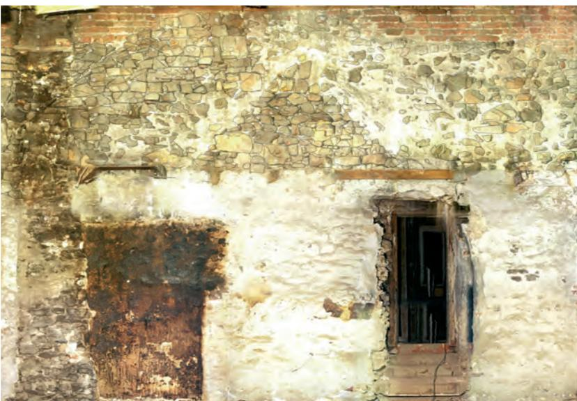
Ausschnitt der Fotogrammetrie der Westansicht des Steinturms. Im oberen Bereich zeichnen sich die beiden spitzgiebeligen Dachansätze des Anbaus ab. Der obere Abschluss zeigt die unregelmäßige Abbruchkante des Steinturms von Bauphase 2 und das darauf aufgesetzte spätmittelalterliche Ziegelmauerwerk von Phase 3.
