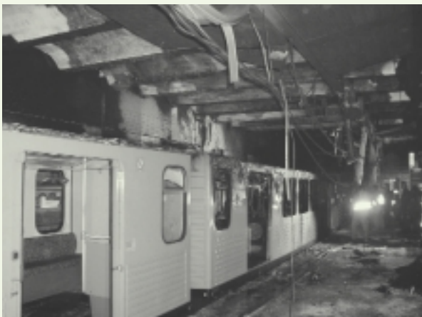
Берлин - BVG: станция "Deutsche Oper" после пожара (2000)
