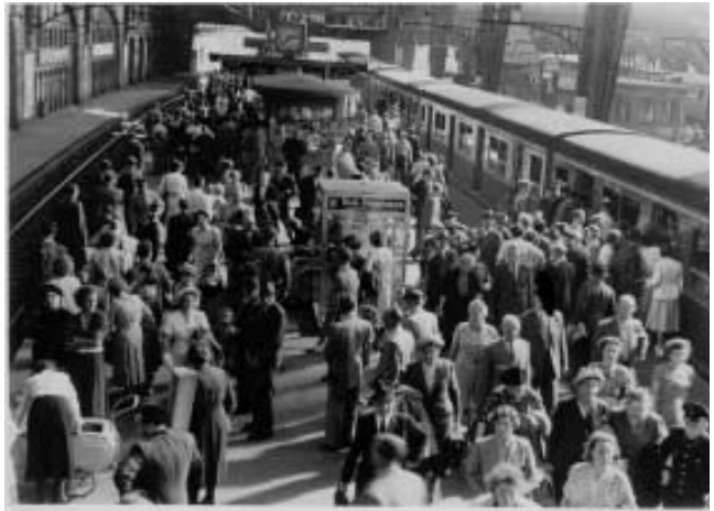
Quelle: Deutsche Bahn AG, Frankfurt am Main
