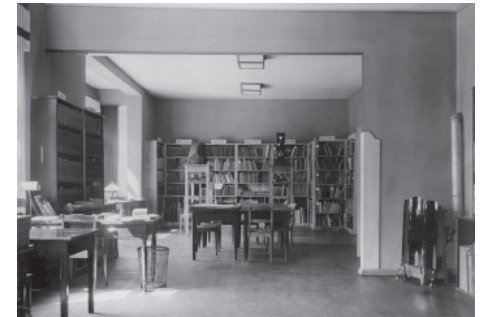
Hauptarbeitsraum des Greifswalder Kunsthistorischen Seminars in der Bahnhofstr.2/3; April 1934
