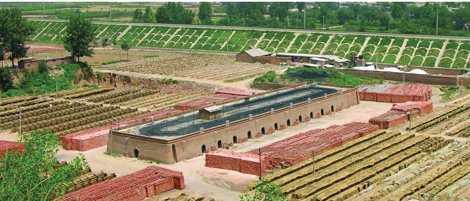
La briqueterie Liucun Hollow (Chine). Le FEM a participé à la construction de ce four à briques à haut rendement énergétique et a facilité la diffusion de cette technologie au Bangladesh.
