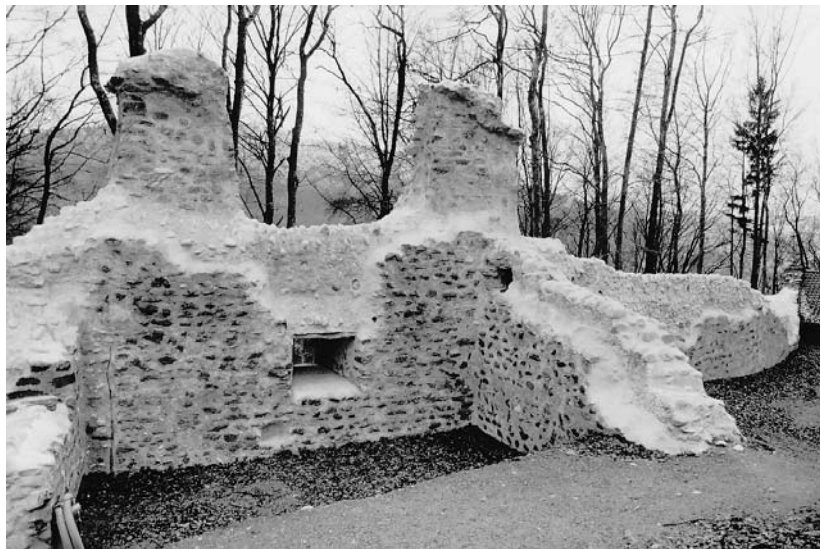
Südmauer der Grünenberg vom Hof aus gesehen nach der Sanierung 1993. Foto Margrit Kohler, Langenthal.
