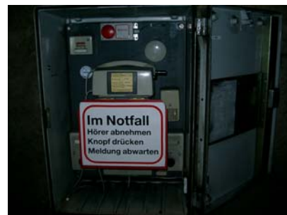
Abbildung 30: Notruffernsprecher auf bestehenden SFS
