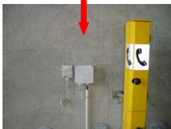
Abbildung 23: Anschlussdose für Fernsprecher
