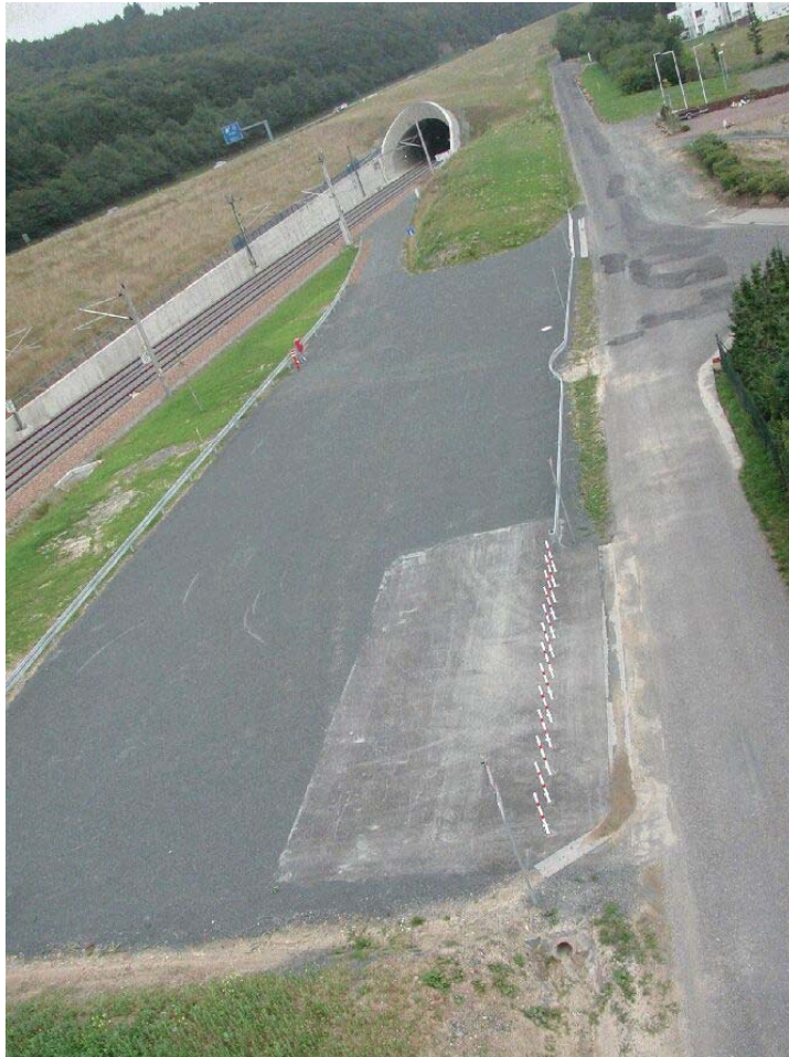
Abbildung 11: Rettungsplatz am Idsteiner Tunnel (vgl. auch Abbildung 29)
