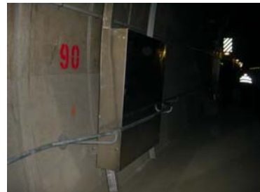
Abbildung 1: Handlauf, Sicherung von Abspannungen
