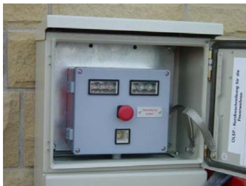
Abbildung 13: Anzeige- und Bedientafel der OLSP
