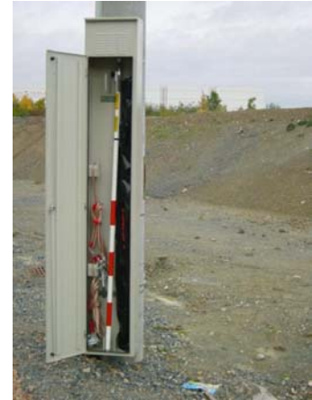
Abbildung 16: Mobile Erdungsvorrichtungen
