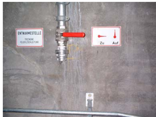
Abbildung 19: Schlauchanschlusseinrichtung
