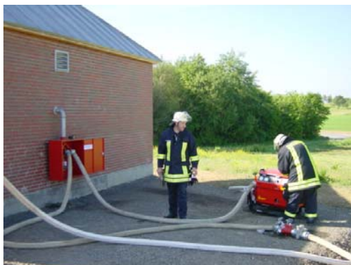
Abbildung 18: Einspeisen in Löschwasserleitung
