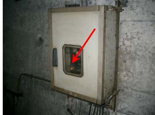
Abbildung 32: Lichtschalter in Tunneln der SFS
