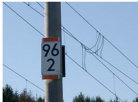
Abbildung 24: Hektometertafel mit NBÜ-Kennzeichnung
