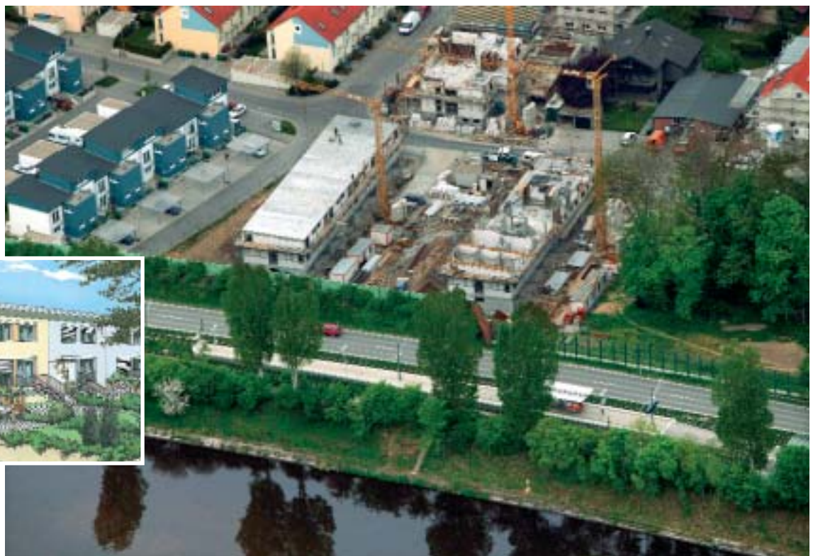
Neubau von 16 Reihenhauteilen außerhalb der Gemarkung von Stuttgart in Remseck-Aldingen
