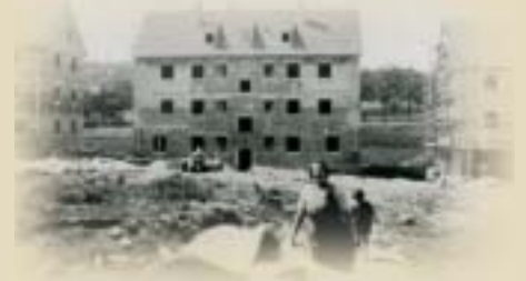
Stuttgart-Feuerbach, Föhrichhof im Rohbau, Aufnahme von 1939.
