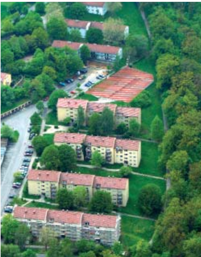
S-Birkach, Bestandssanierung mit Ergänzungsneubau
