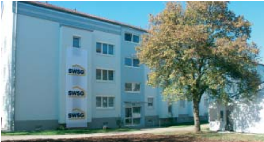
Modernisierung im bewohnten Zustand
