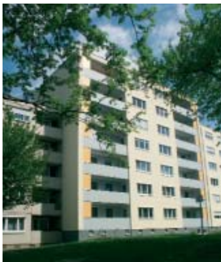
S-Dürtlewang, Herschelstraße (Bestandssanierung)
