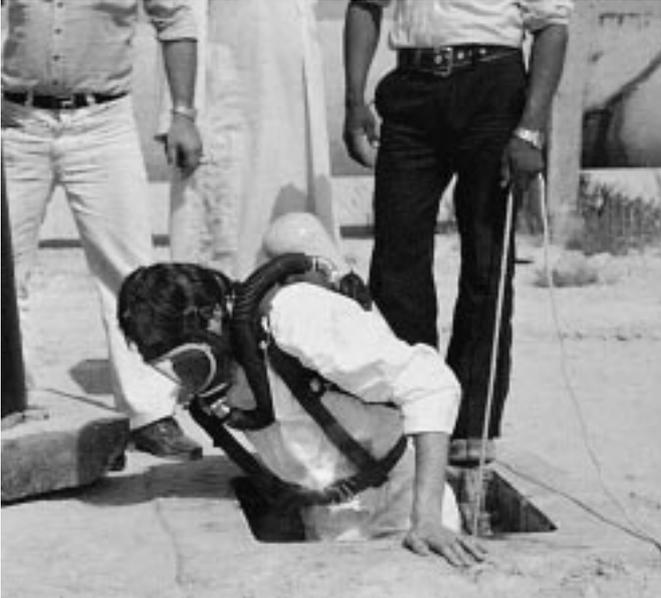
**Bild 2: Sulfidproblem Arbeitssicherheit**
