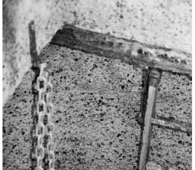
**Bild 5: Sulfidproblem Korrosion (Schachtbauwerk am Ende einer Druckleitung)**
