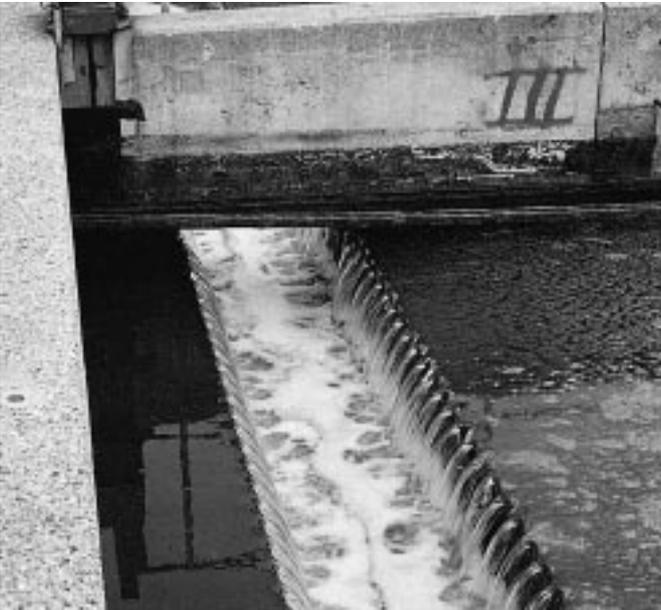
**Bild 3: Sulfidproblem Blähschlamm**
