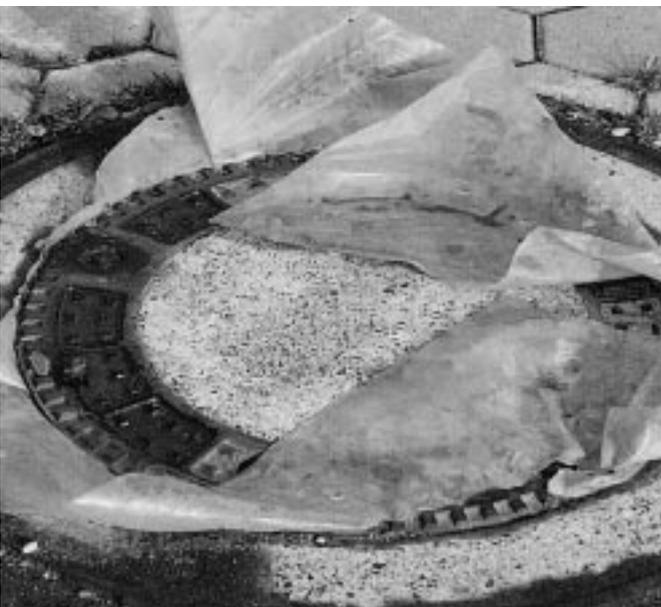
**Bild 4: Sulfidproblem Geruchsbelästigung**
