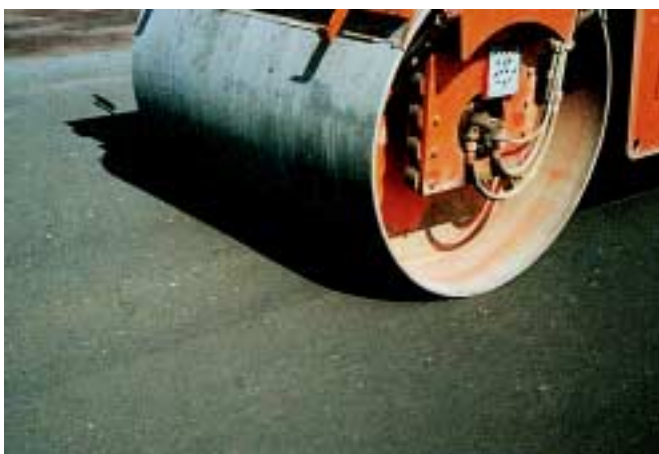
Bild 7: Endverdichtung mit Walze
