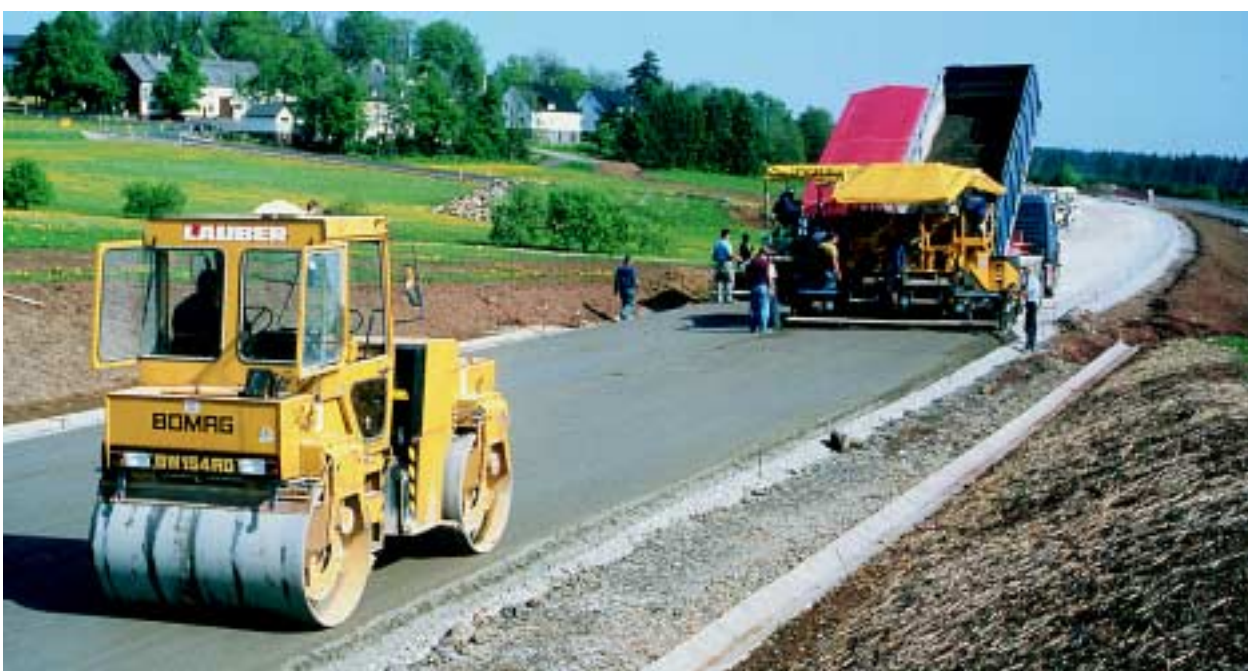
Bild 1: Erprobungsstrecke "Walzbeton als Tragschicht mit dünnem Asphaltbelag" auf der B 54 im Westerwald
