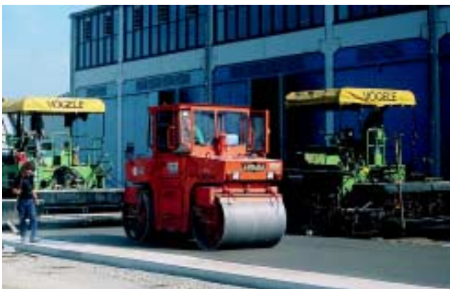
Bild 3: Streifenweiser Einbau von Walzbeton für eine direkt befahrene Abstellfläche
