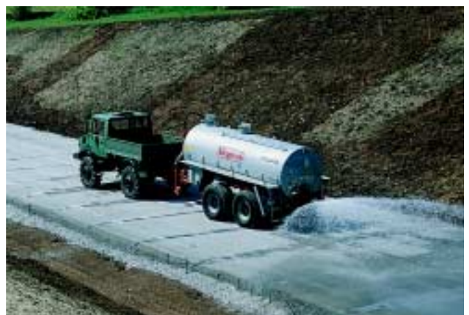
Bild 8: Nassnachbehandlung einer Walzbetonfläche
