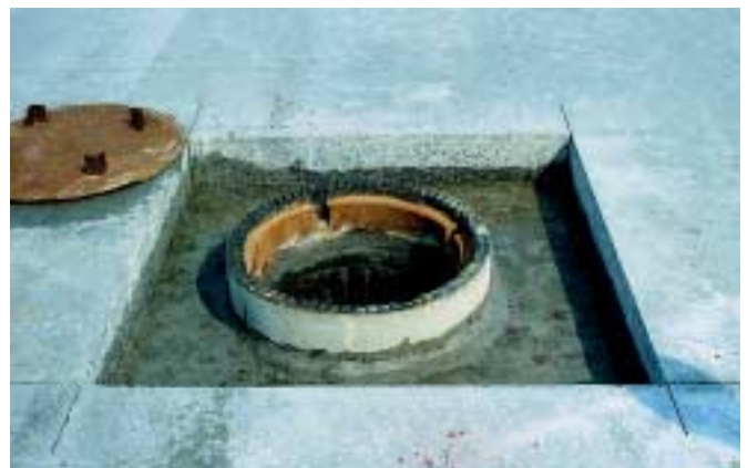
Bild 4: Ausgeschnittene Öffnung im Walzbeton zum Einbau des oberen Schachtrings, anschließende Verfüllung mit Fließbeton.
