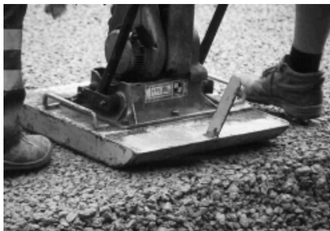
Bild 4b: Einrütteln der Querfugen
