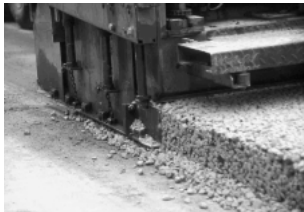
Bild 2: Einbau der DBT mit Straßenfertiger
