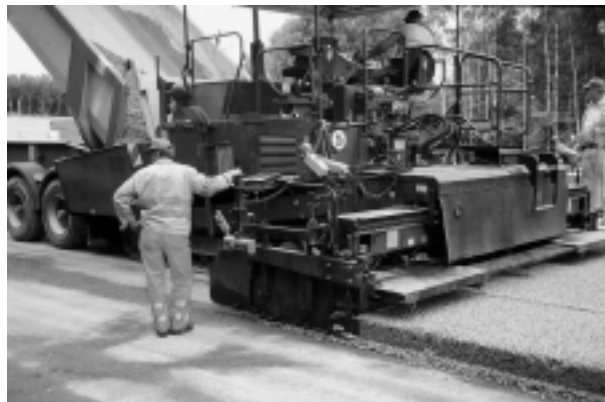
Bild 1: Einbau einer Dränbetontragschicht im Beschleunigungstreifen einer Autobahn-Anschluss-Stelle
