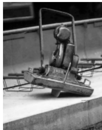
Bild 4b: Einrütteln der Querfugen
