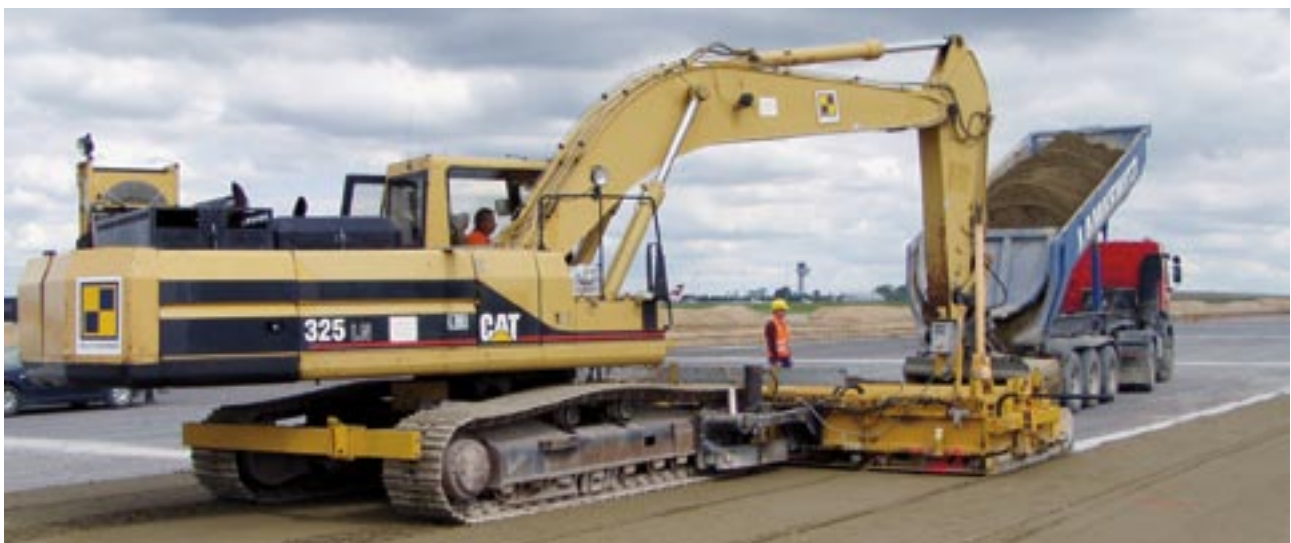
Bild 1: Einbau einer hydraulisch gebundenen Tragschicht mit Multi-Talent
