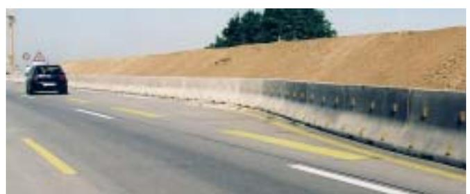
**Bild 5: Temporärer Einsatz von BSW-Fertigteilen an Arbeitsstellen**
