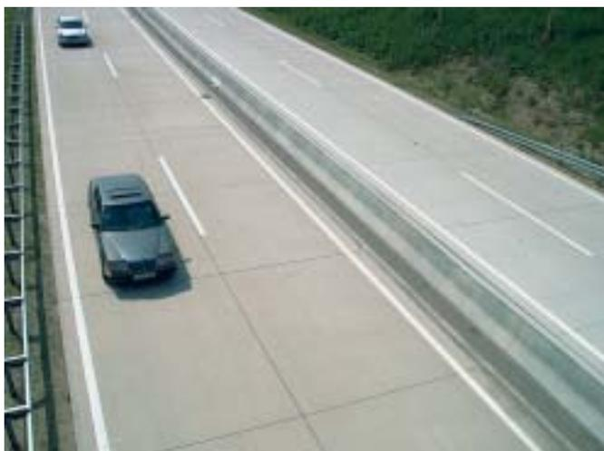
**Bild 2: Betonschutzwand im Mittelstreifen**
