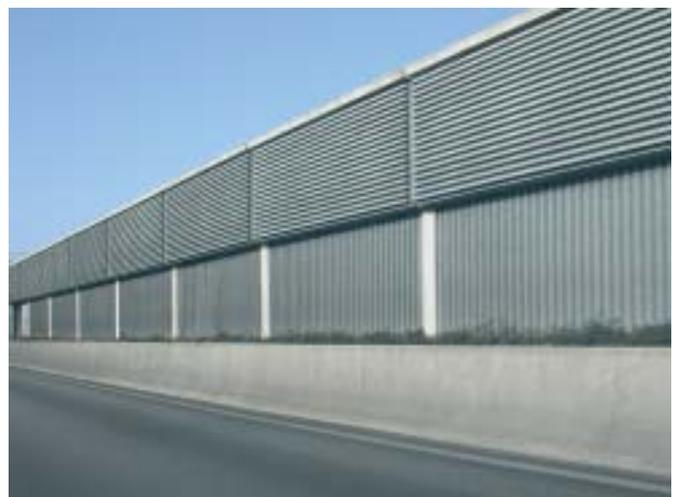
**Bild 4: BSW in Kombination mit Lärmschutzwand**
