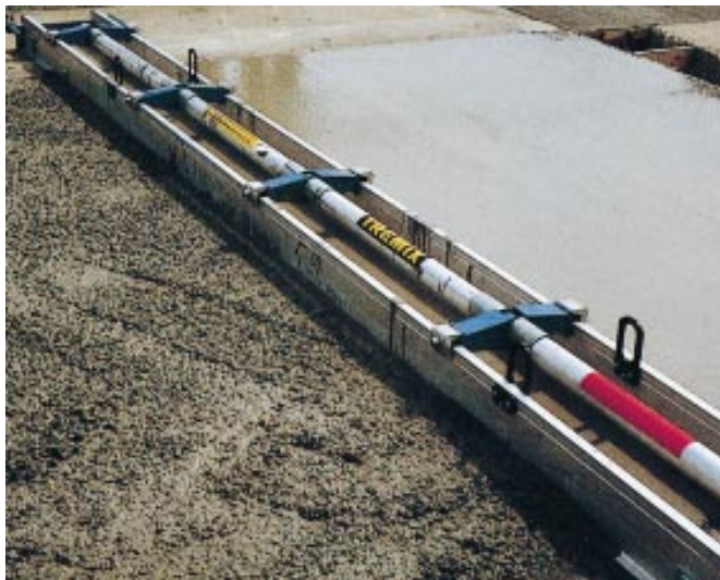
Bild 2: Zum Verdichten und Abziehen sind Doppelbohlen besonders gut geeignet.
