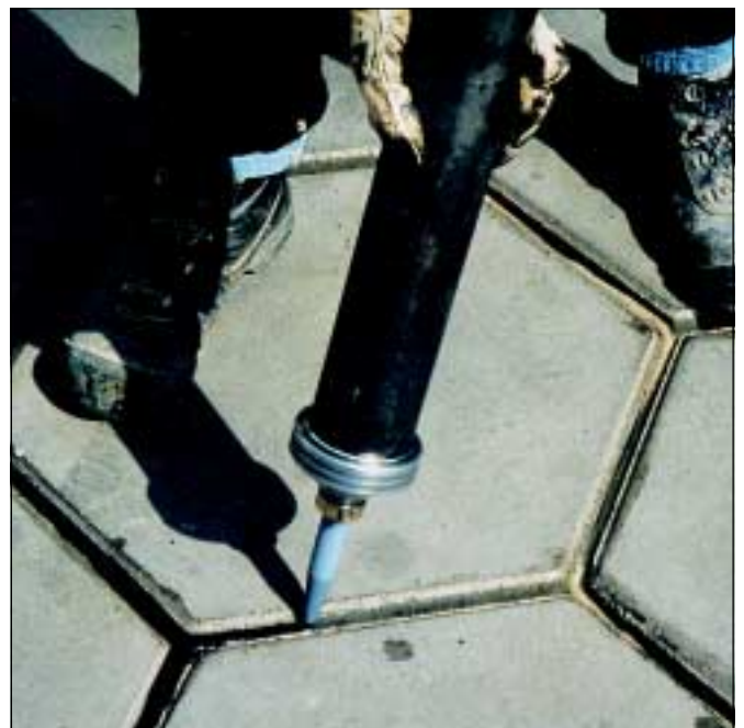
Bild 7: Verfüllen der Fugen mit Polysulfiddichtstoff
