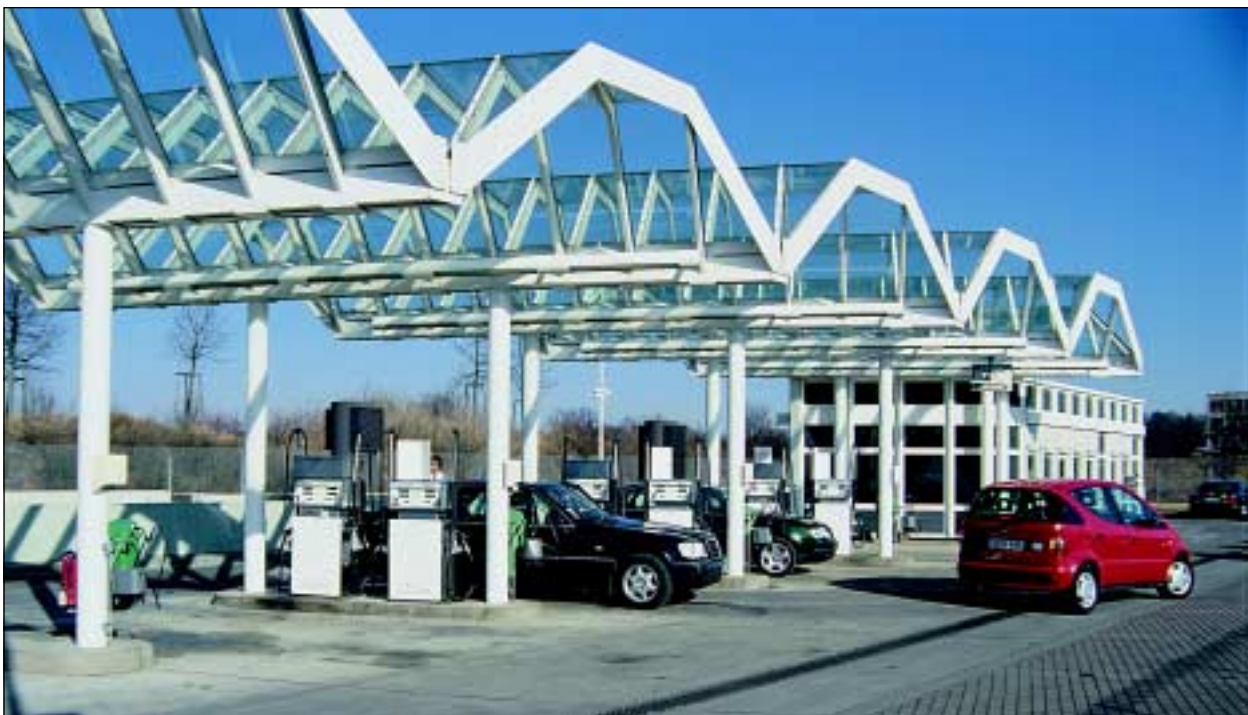
Bild 1: Abfüllplatz mit Ortbetonplatte
