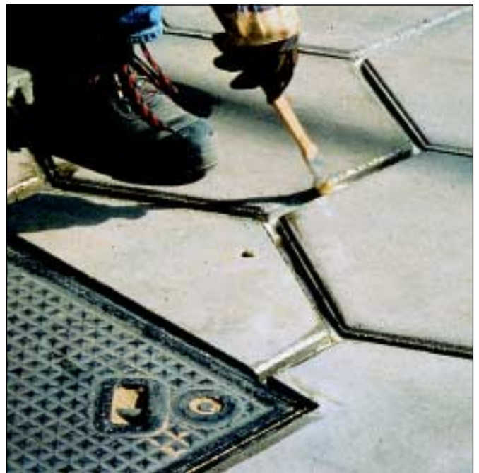
Bild 6: Aufbringen des Primers zur besseren Flankenhaftung
