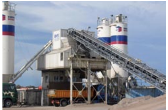
Bild 4: Mischanlage zur Herstellung von Straßenbeton
