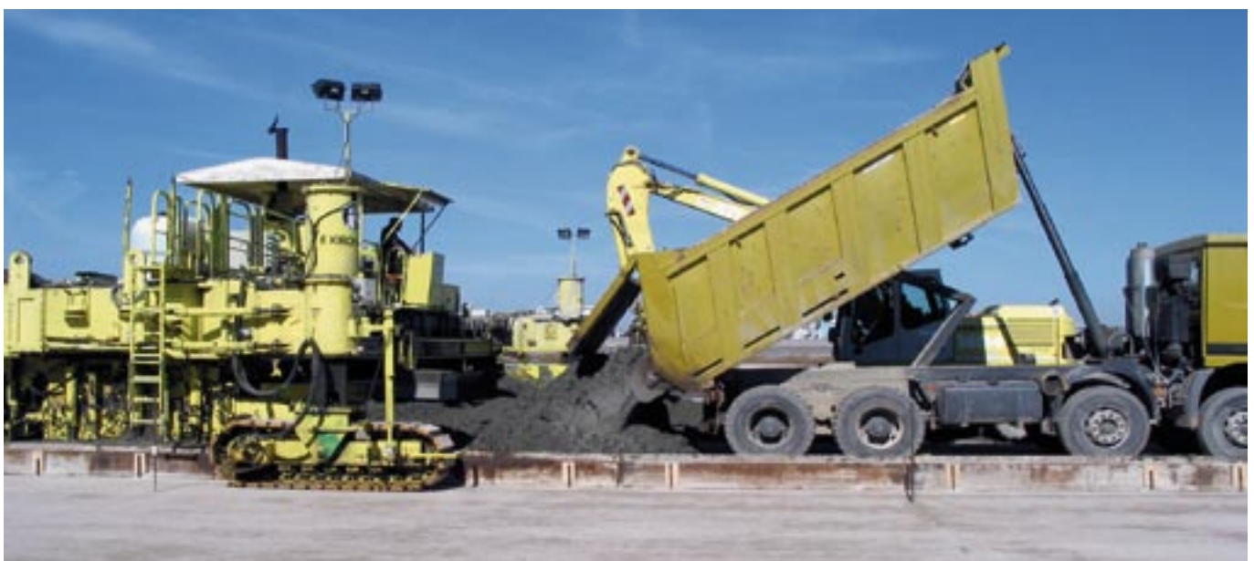
Bild 2: Übergabe des Betons auf der Baustelle
