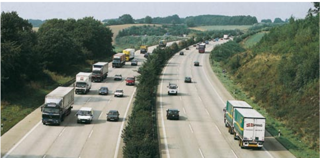
Bild 1: Betonfahrbahndecken sind hell, griffig, dauerhaft und Lärm mindernd
