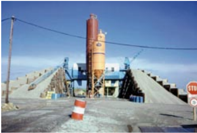
Bild 3: Lagerung der Gesteinskörnungen einer Mischanlage
