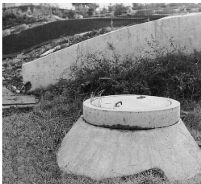
Bild 3: Flachsilo mit Querrinne, Gärtsaftabscheider und Gärtsaftauffangbehälter
