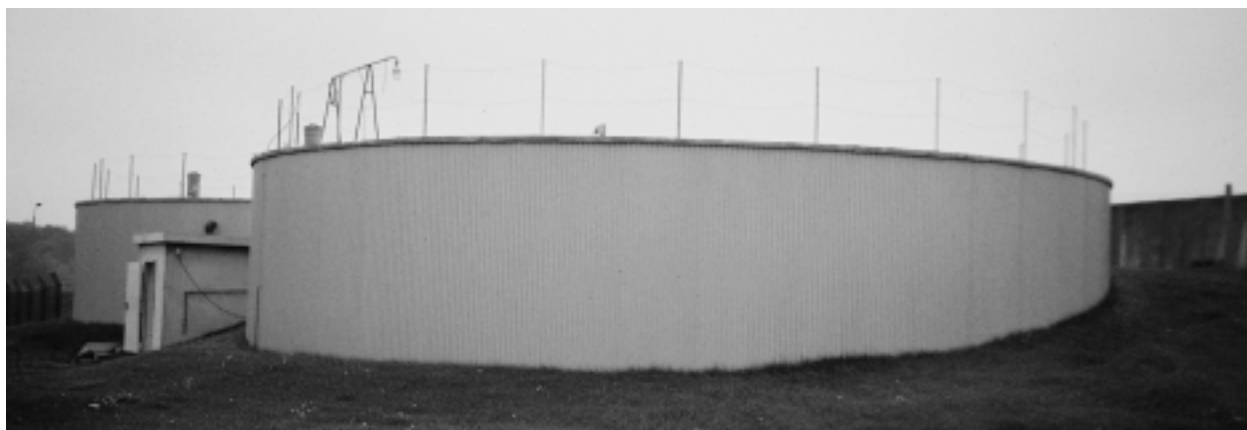
Wärme gedämmte und verkleidete 800-m 3 -Stahlbetonfermenter einer Durchflussanlage, in der Mitte Raum für Steuer- und Regeltechnik
