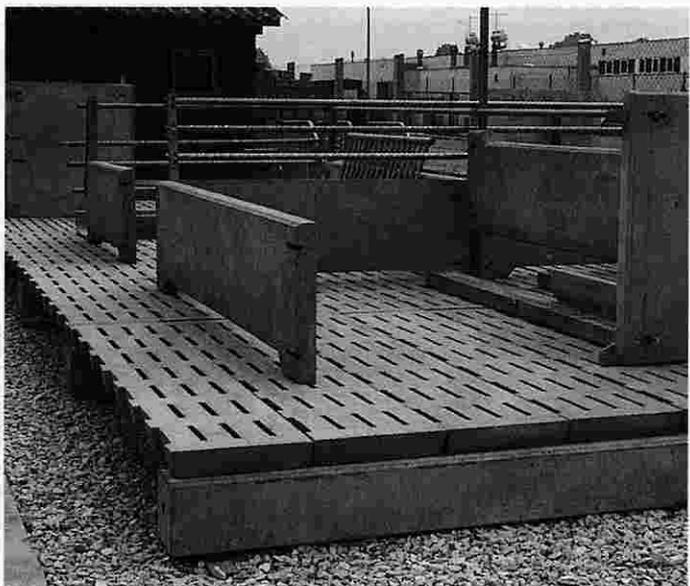
**Bild 8: Schweinespaltenböden – die aufgesetzten Buchtentrennwände bestehen aus Betonbauteilen**
