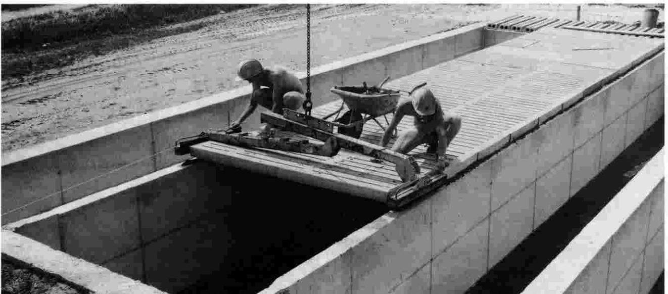
**Bild 1: Montage eines Rinderspaltenbodens mit einer Spezialzange. Die Längsspaltenroste werden auf Wänden eines Güllekellers in Mörtel verlegt.**
