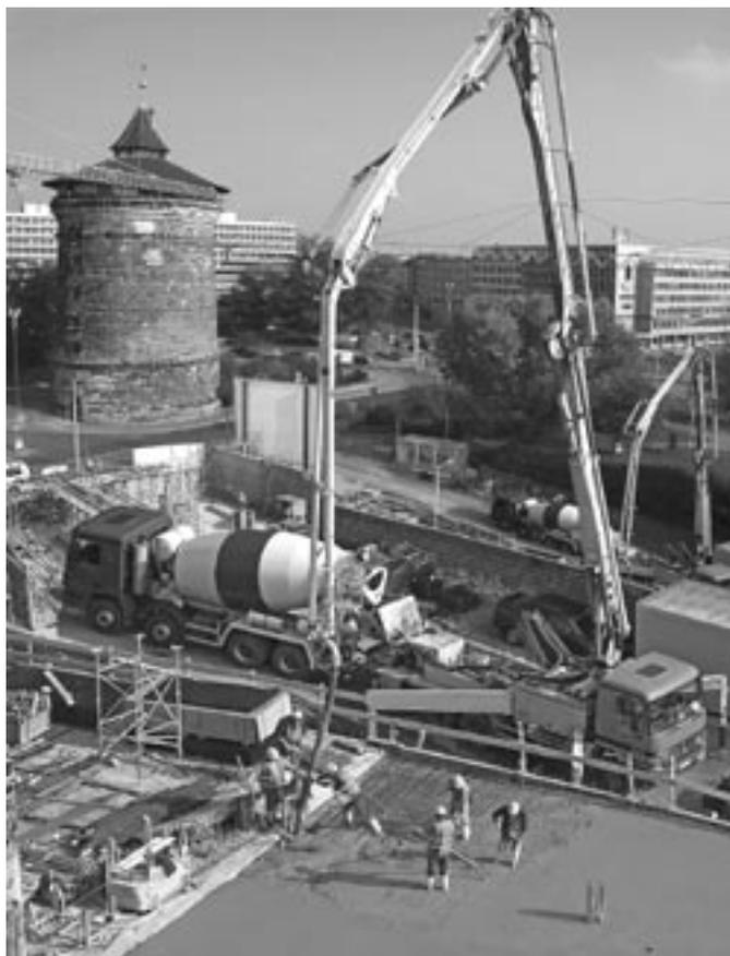
Bild 5: Fördern und Einbringen des Betons mit der Pumpe
