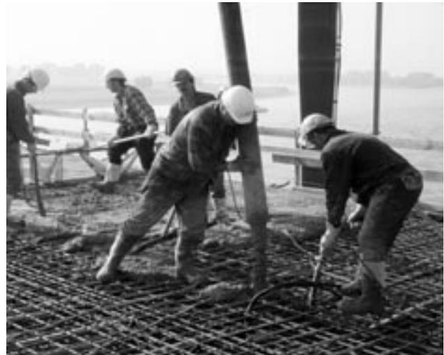
Bild 1: Verarbeiten von Beton auf der Baustelle
