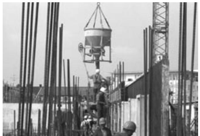
Bild 4: Fördern des Betons mit dem Kübel
