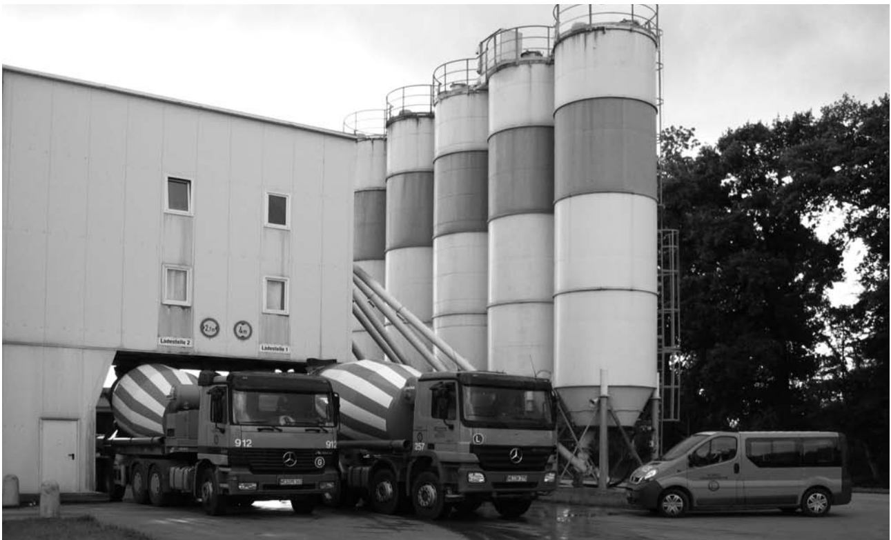
Bild 1: Lieferung von Transportbeton mit dem Fahrmischer
