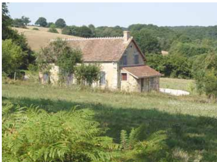
Bâtiment agricole traditionnel avec couverture en tuiles plates cheminée en briques et murs en moellons de schiste enduits à la chaux (Le Carroir, Sidiailles)
