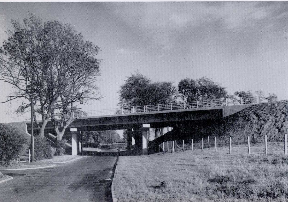
PLATE 10. D'URTON LANE BRIDGE.
